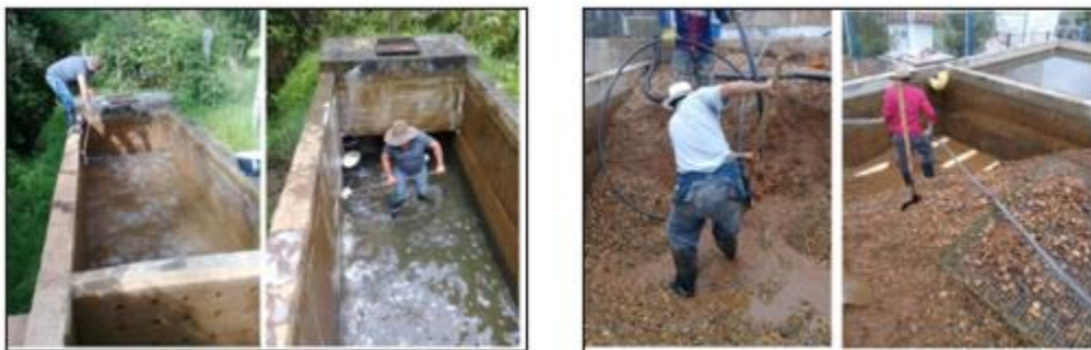
Ilustración 14. Imágenes de Mantenimiento a la PTAP urbana de Floresta
