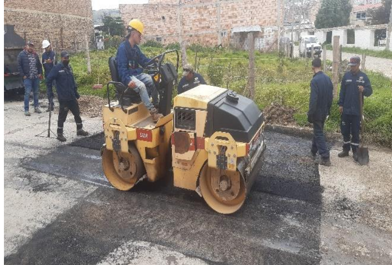
Fig. 48- Compactación de la mezcla asfáltica sobre terreno.
