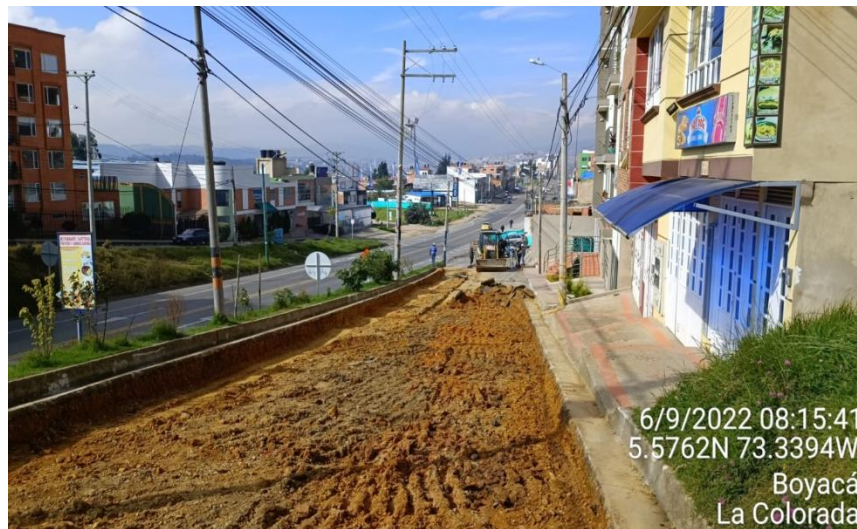
Fig. 51- Extracción de material de subrasante tramo 2B La Colorada.
