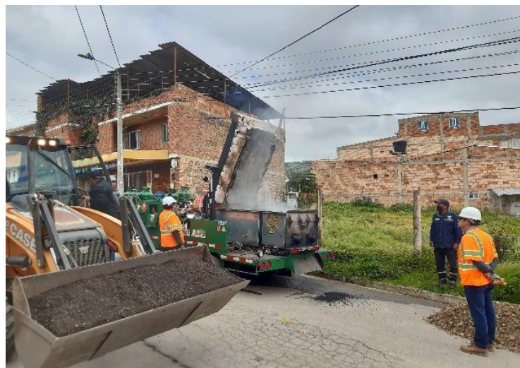
Fig. 46- Proceso de fabricación de mezcla primera descarga.
