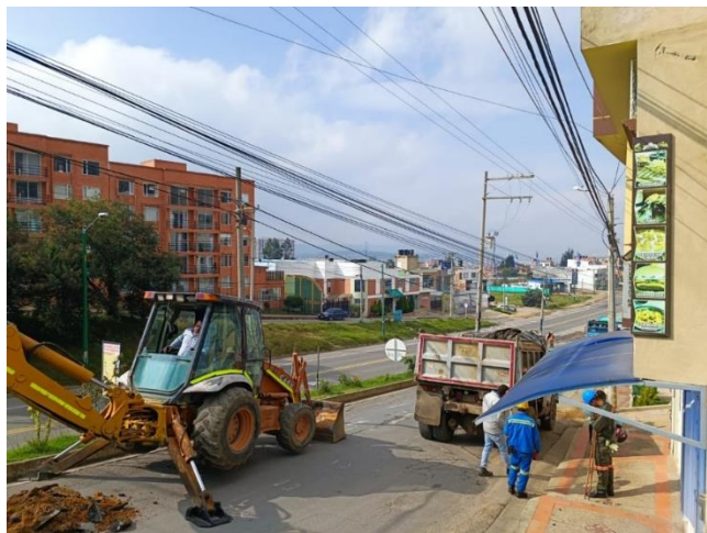
Fig. 49- Extracción carpeta asfáltica Tramo 2B La Colorada.
