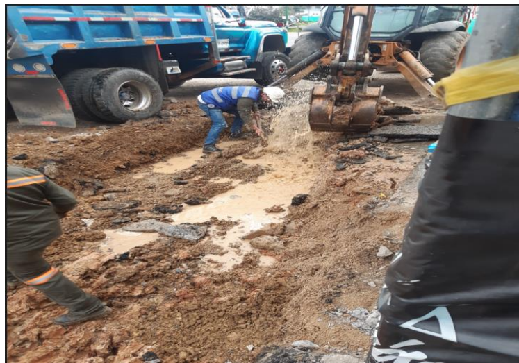
Fig. 53- Intervención por ruptura de manguera de acometida tramo 2B La Colorada.
