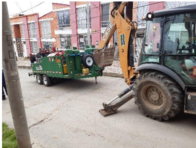
Fig. 44- Traslado de maquinaria MARU al tramo prueba.
