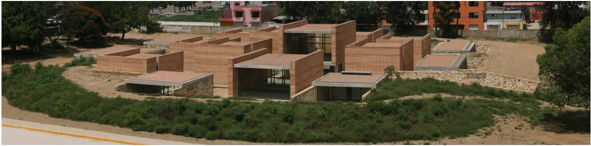
Figura 14. Imagen vista general de la escuela de artes de Oaxaca
