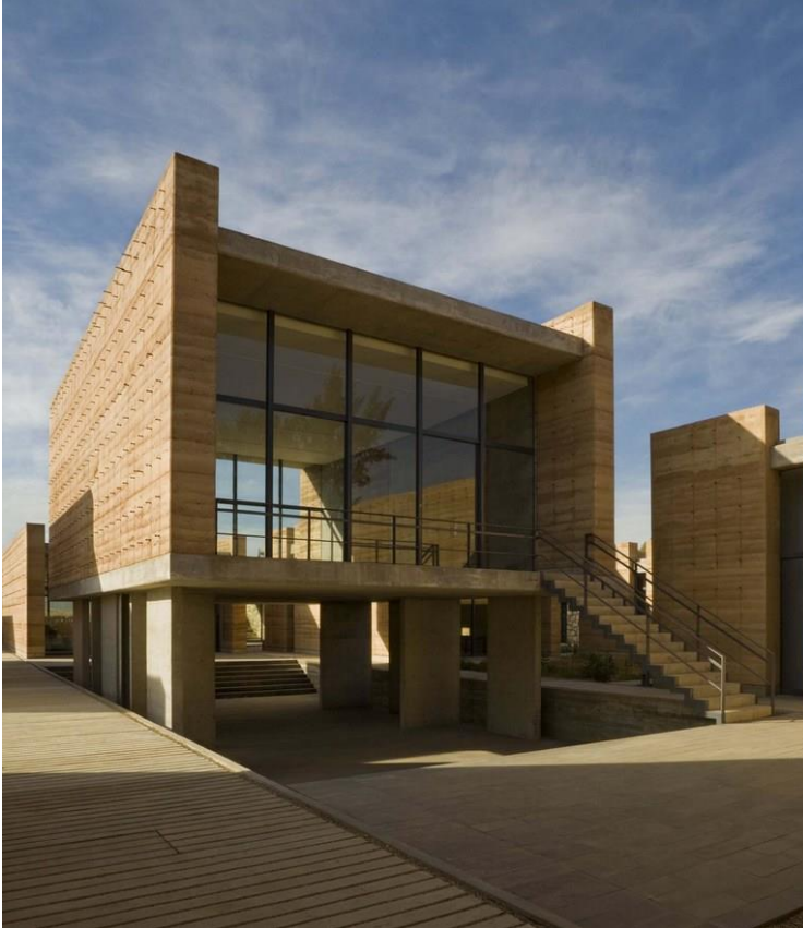
Figura 13. Imágenes del módulo central de la escuela de artes visuales de Oaxaca
