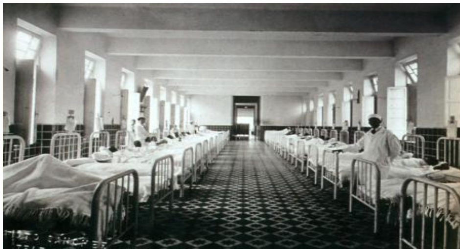
Figura 34. Arquitectura hospitalaria de la época
