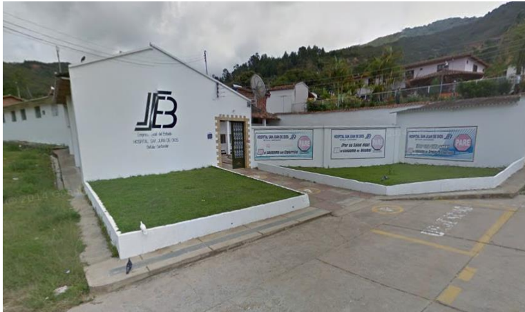
Figura 6. Hospital San Juan de Dios
