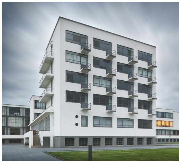
Figura 2. Edificio de la Bauhaus en Dessau. Vista exterior
