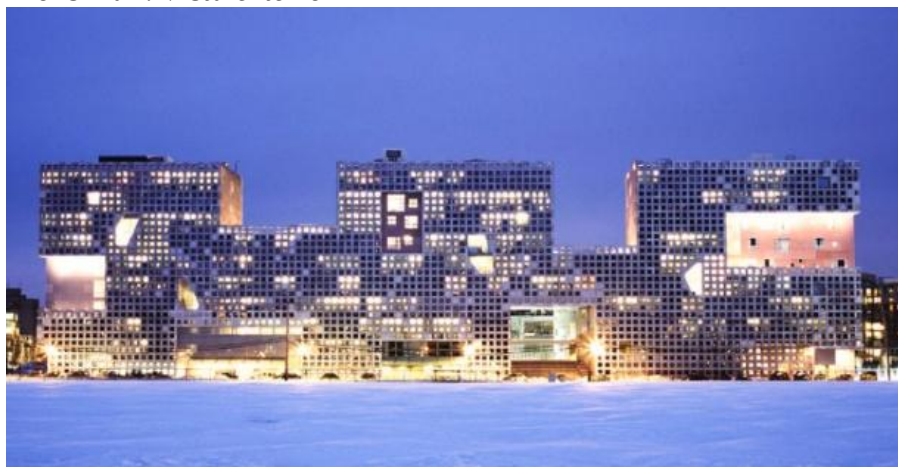
Figura 6. Simmons Hall. Vista exterior
