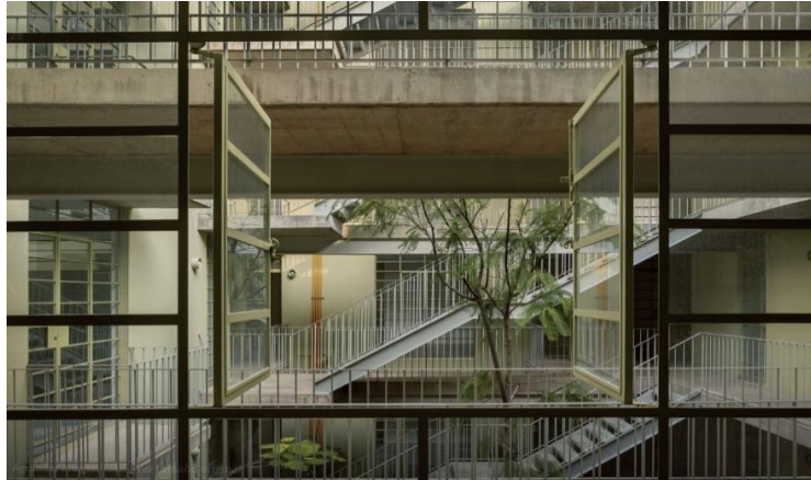
Figura 23. Edificio XX de noviembre, Vista Interior
