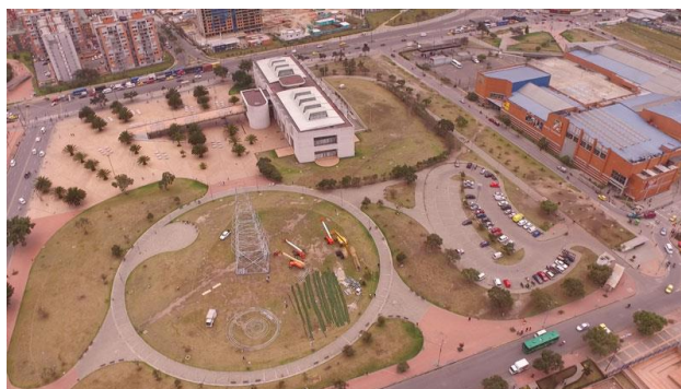
Figura 14. Vista aérea biblioteca el tintal. Bogotá.
