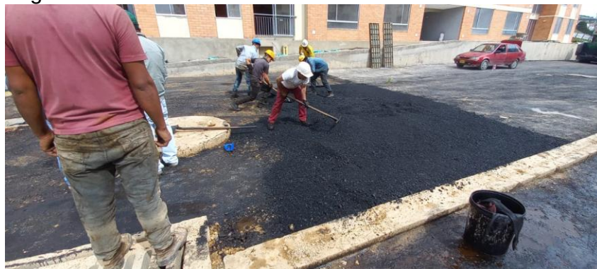
Figura 28. Cuadrilla extendiendo mezcla asfáltica MDC-25
