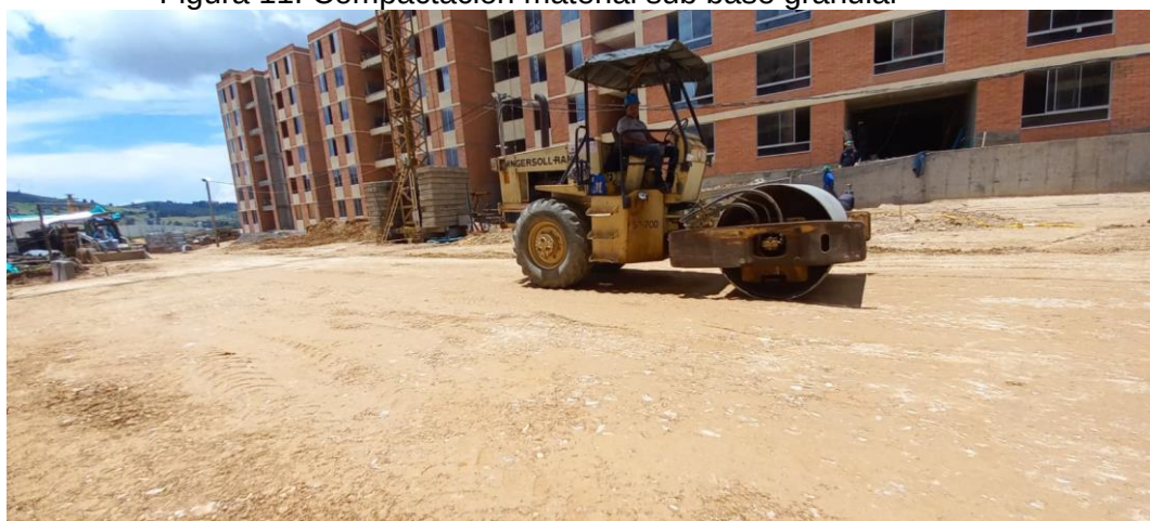
Figura 11. Compactación material sub base granular
