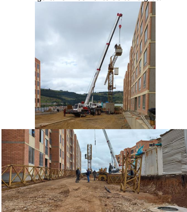
Figura 43. Desmote de torre grúa
