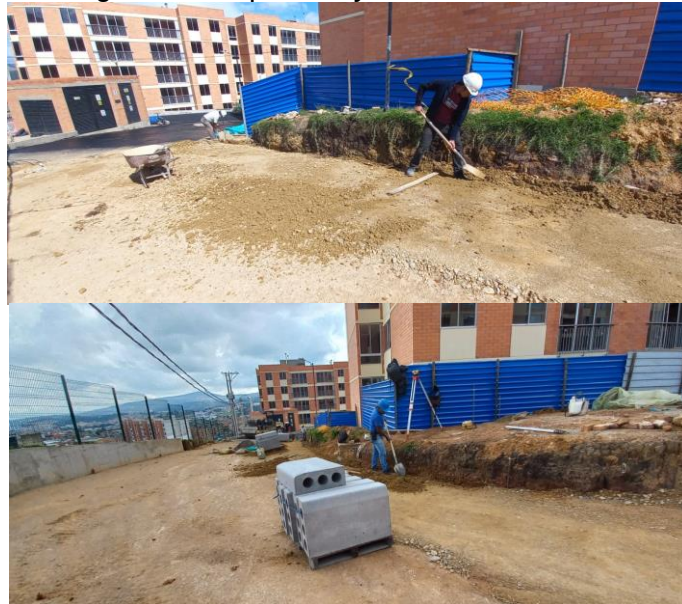
Figura 34. Replanteo y excavación bordillo
