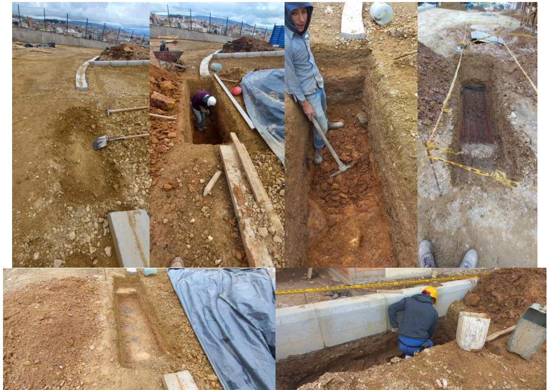
Figura 39. Excavaciones de sumidero
