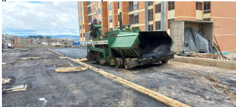
Figura 25. Finisher usada para instalación de mezcla asfáltica
