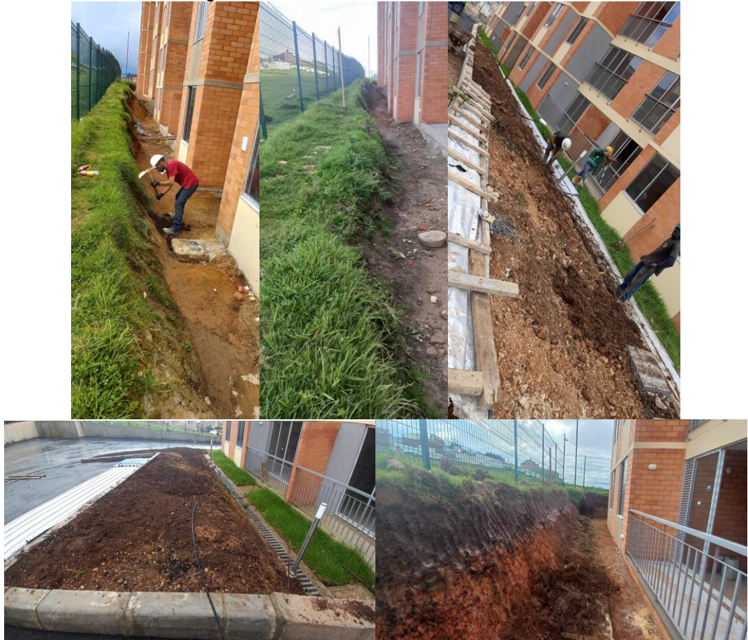
Figura 47. Perfilada terreno de zona verde
