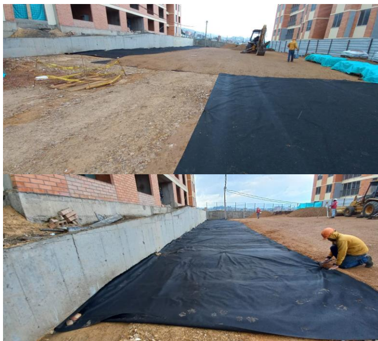
Figura 7. Instalación de Geotextil NT 1800
