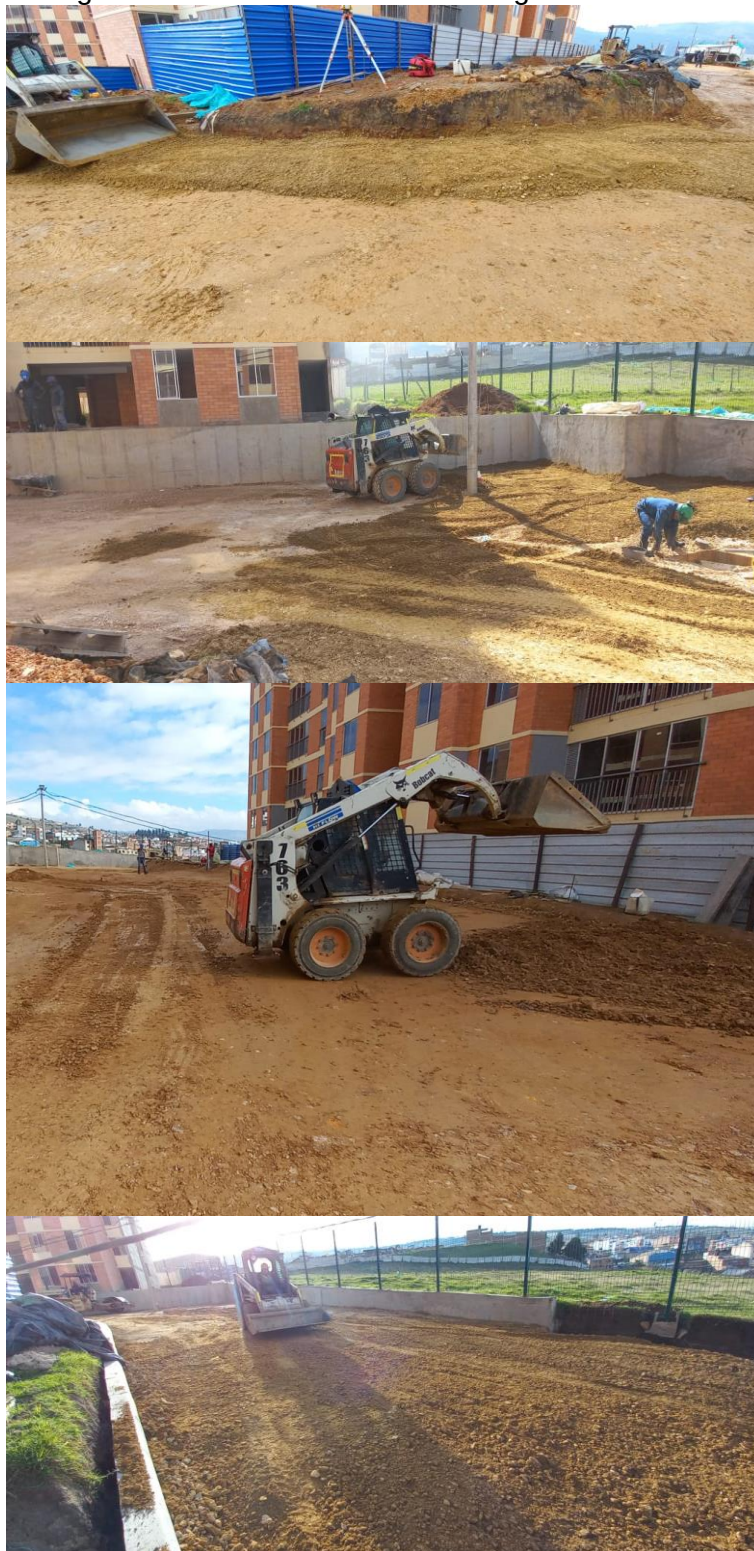
Figura 17. Extensión material base granular
