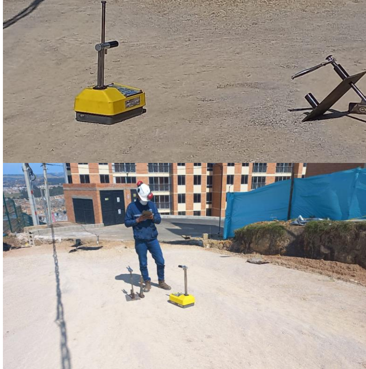
Figura 15. Toma de densidades en campo de sub base granular
