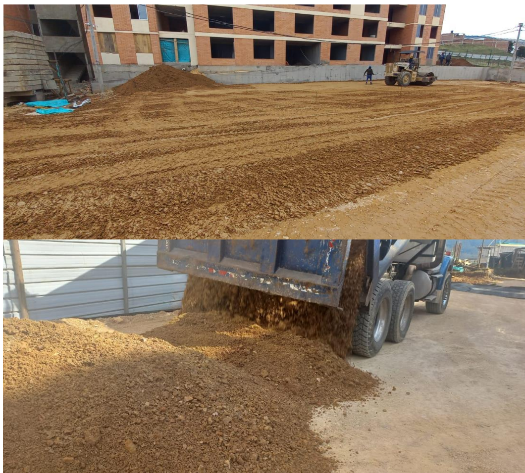
Figura 10. Extensión de material Sub base granular
