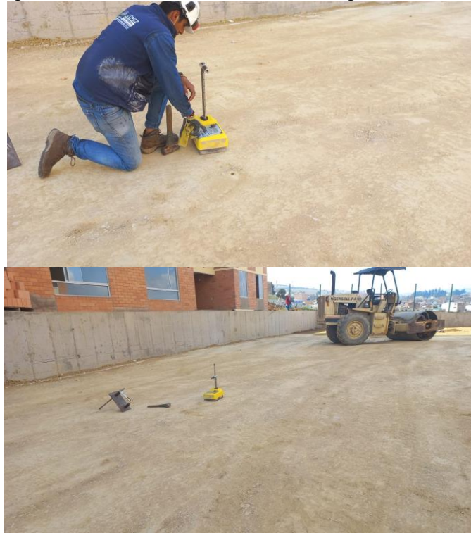
Figura 20. Toma de densidades Base granular
