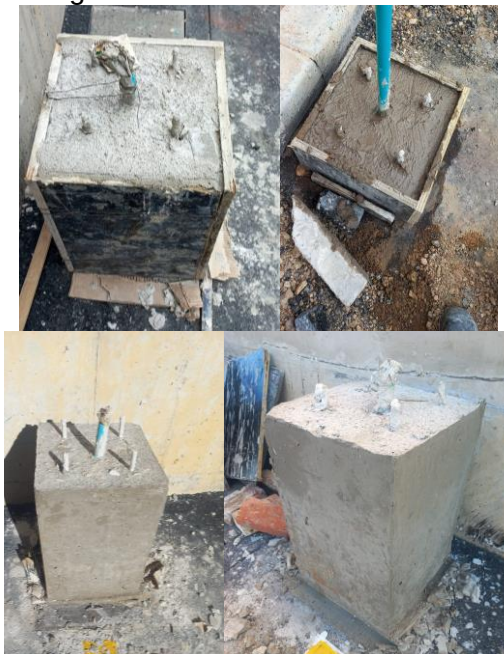
Figura 49. Pedestales realizados
