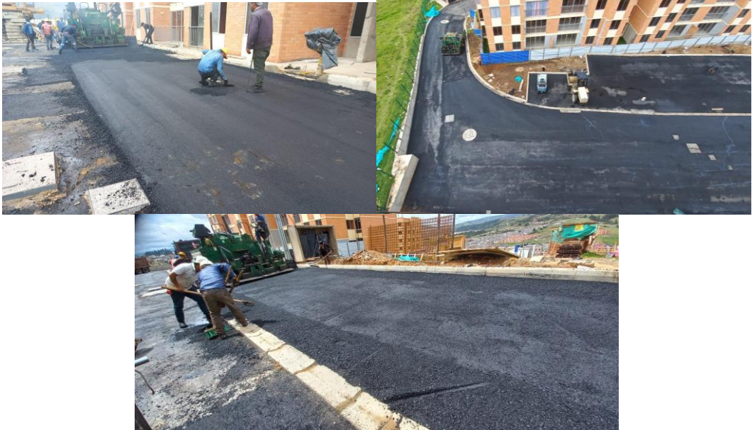
Figura 31. Instalación de MDC-19
