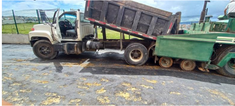
Figura 26. Cargue de asfalto en finisher
