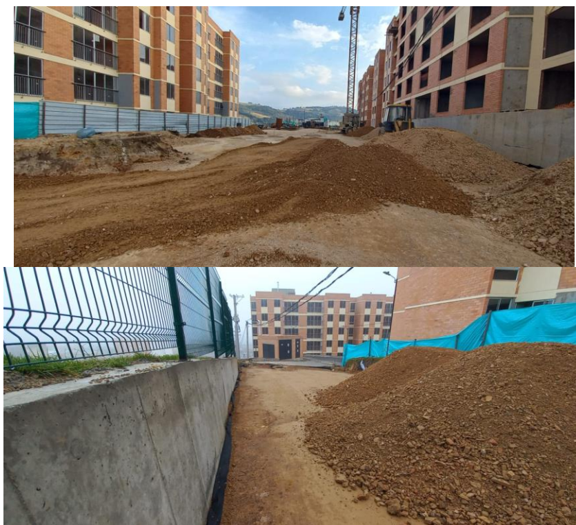
Figura 8. Material Sub Base Acopiado
