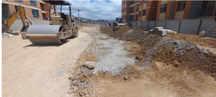
Figura 14. Mejoramiento de Sub base granular con cemento
