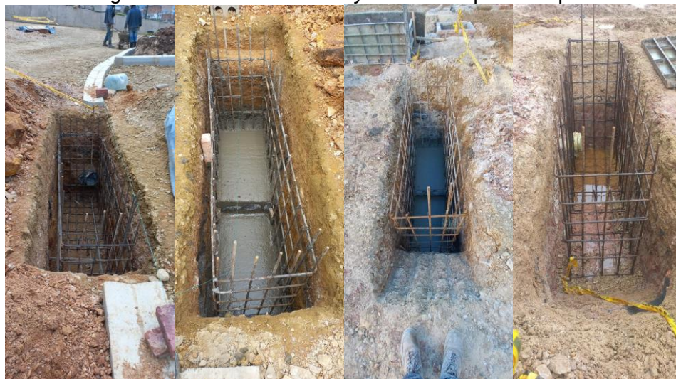
Figura 41. Amarre de acero y fundida de placa de piso
