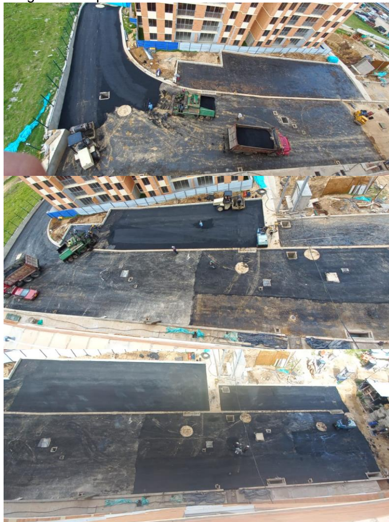
Figura 27. Aplicación de base asfáltica MDC-25
