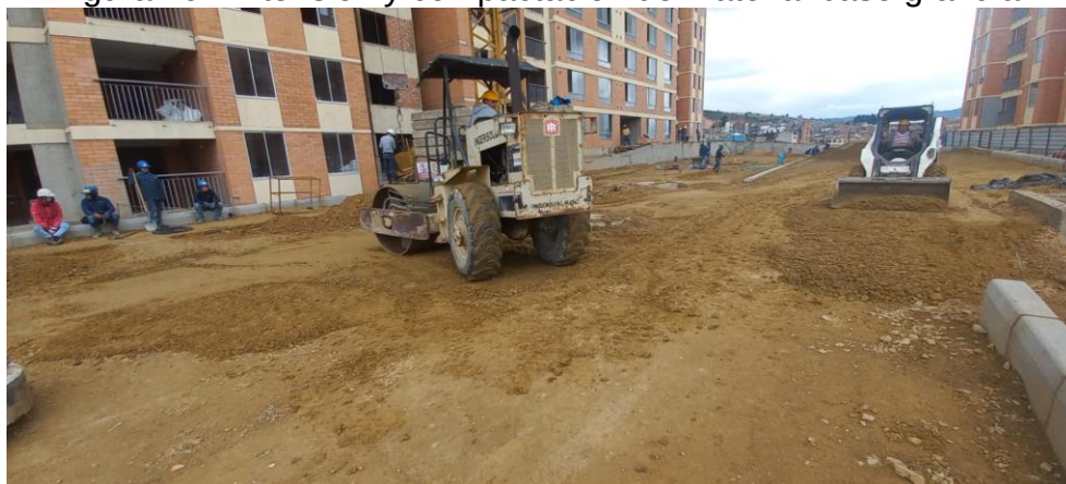
Figura 19. Extensión y compactación de material base granular
