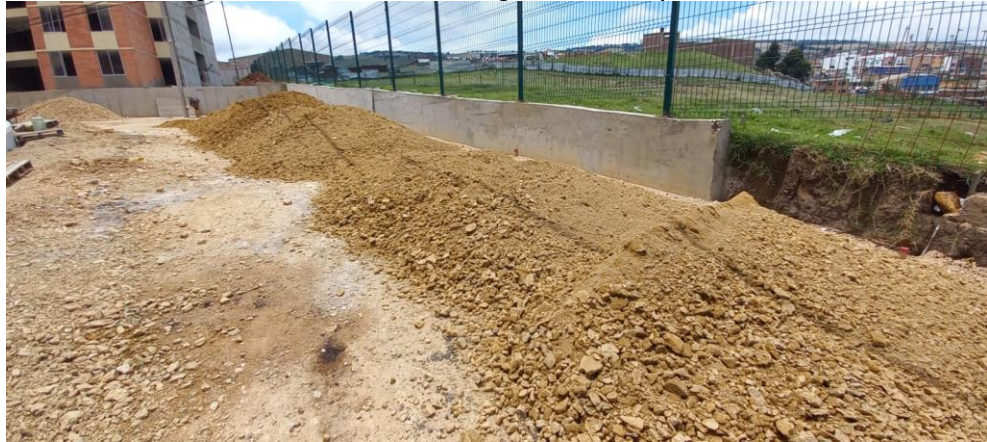
Figura 16. Material Base granular acopiado
