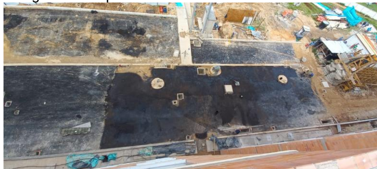
Figura 24. Imprimación zona 2 con emulsión asfáltica
