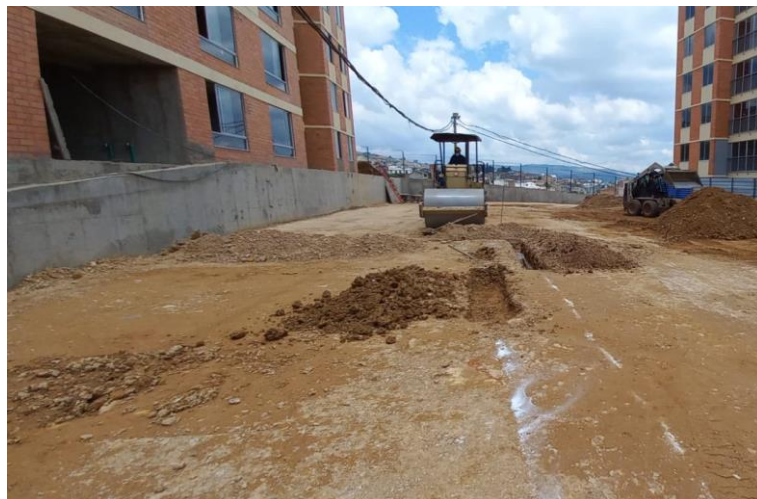
Figura 12. Excavaciones al extender Sub base granular
