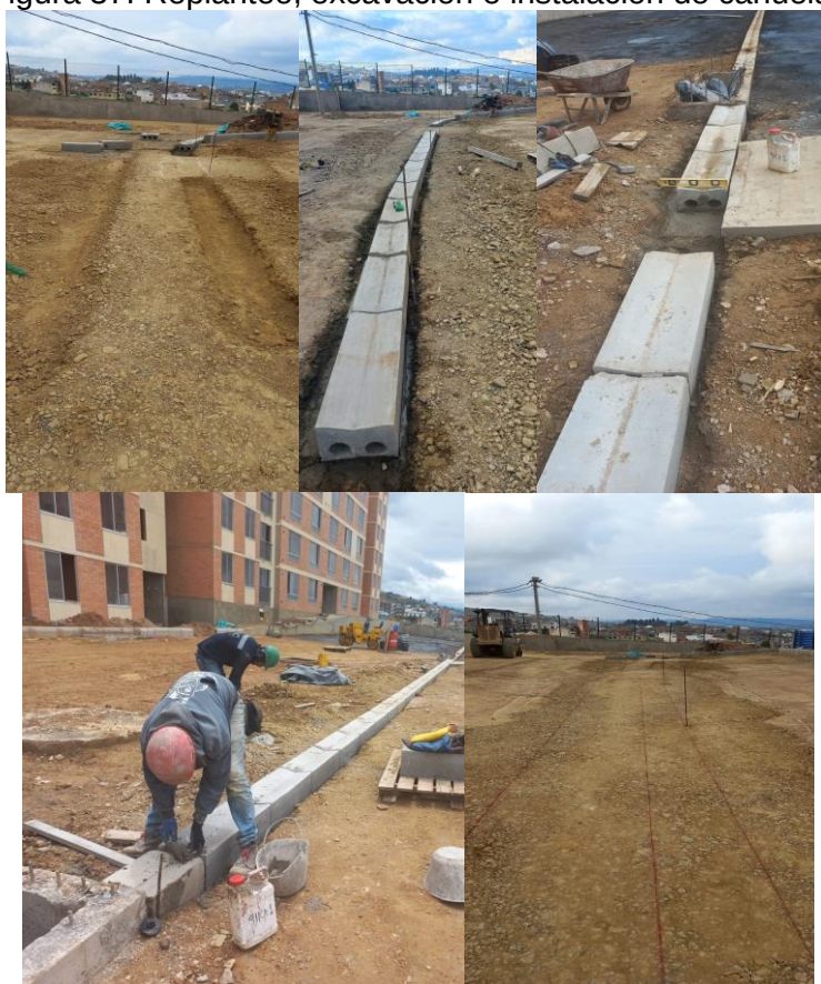
Figura 37. Replanteo, excavación e instalación de cañuelas
