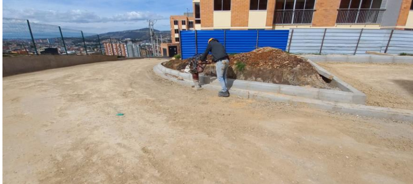
Figura 38. Compactación alrededor de prefabricados instalados
