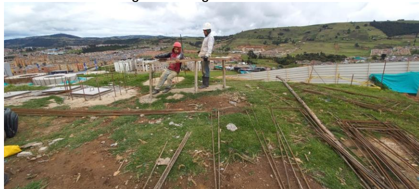
Figura 40. Figurado de acero
