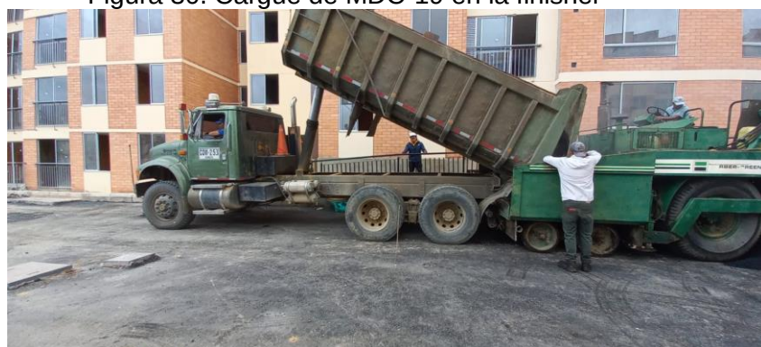
Figura 30. Cargue de MDC-19 en la finisher
