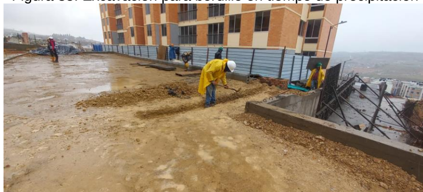
Figura 35. Excavación para bordillo en tiempo de precipitación
