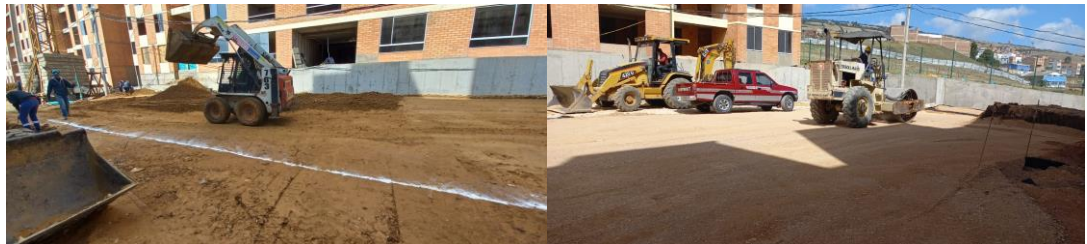
Figura 9. Maquinaria Usada En Obra
