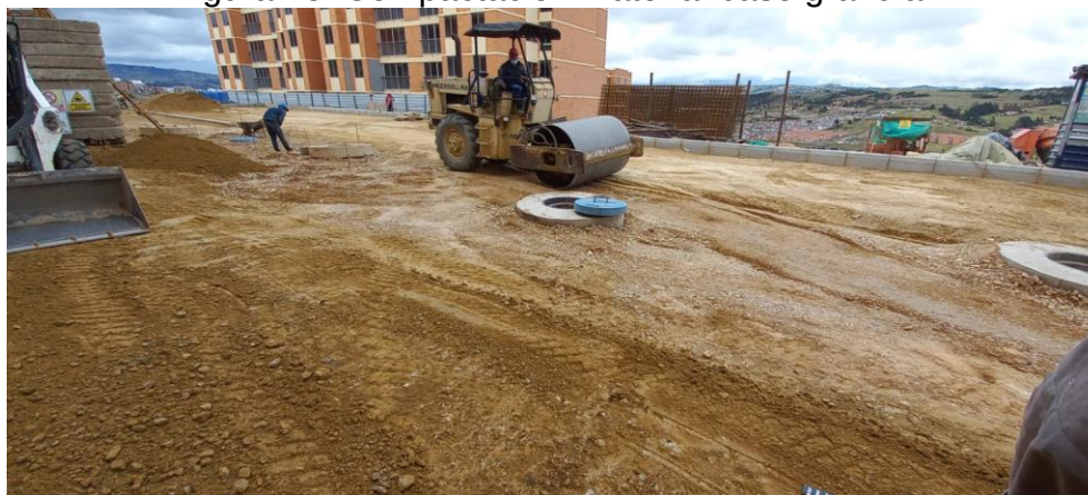
Figura 18. Compactación Material base granular
