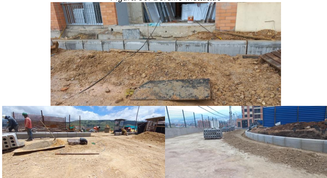
Figura 36. Bordillo Instalado
