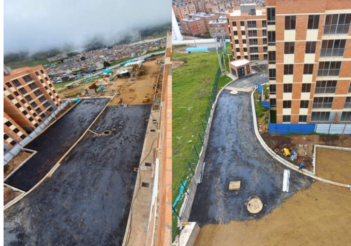
Figura 23. Imprimación zona 1 con emulsión asfáltica
