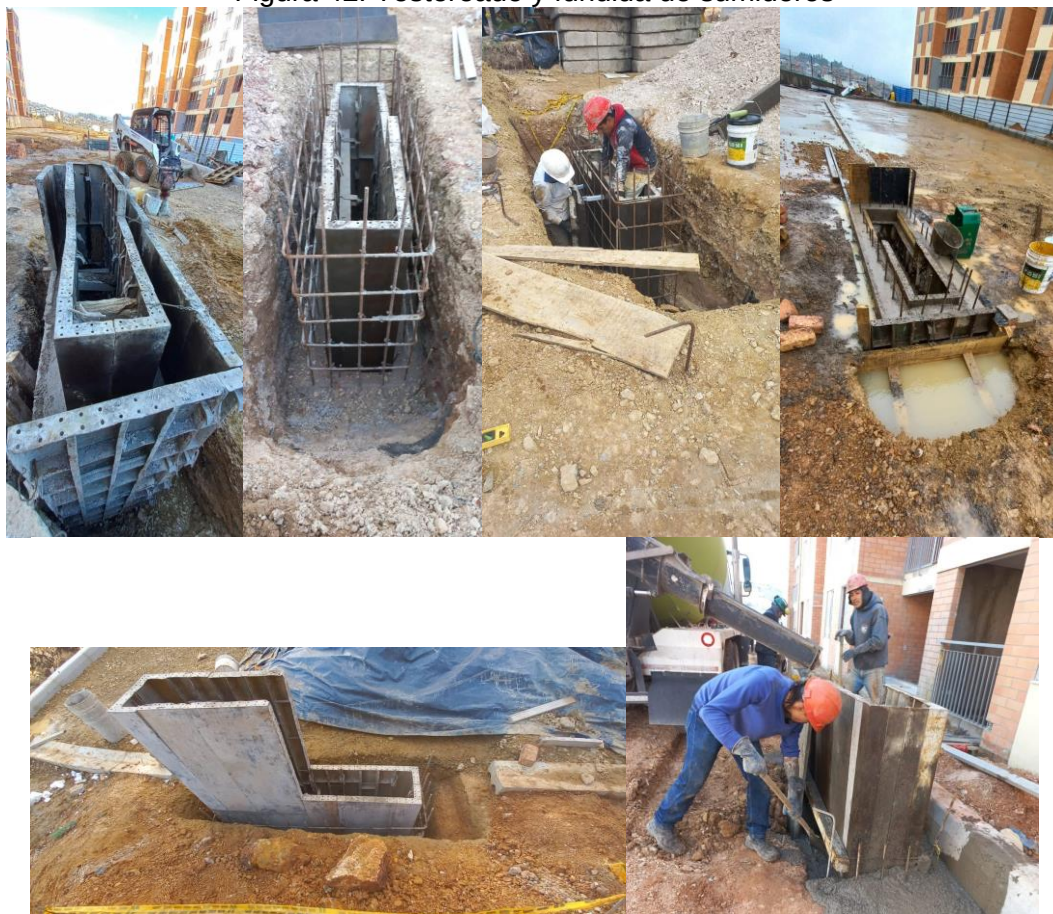
Figura 42. Testereado y fundida de sumideros
