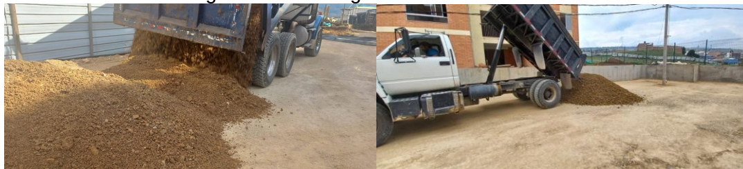
Figura 44. Descargue de material en obra
