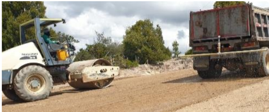
Figura 35. Compactación del terreno.
