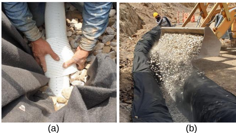
Figura 23. Agregado de la piedra filtro y colocación del tubo de filtro.
