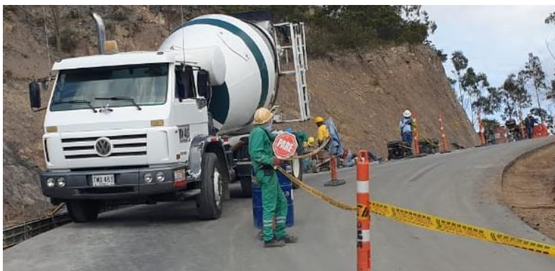
Figura 51. Instalación de colombinas.
