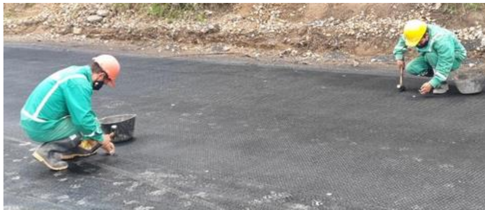
Figura 56. Instalación de geomalla.
