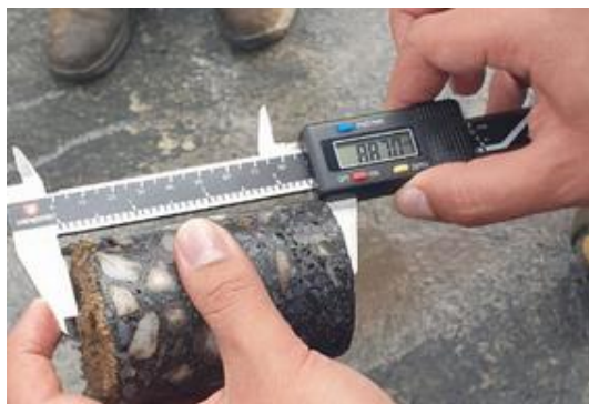
Figura 43. Verificación del espesor.
