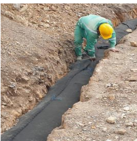
Figura 24. Cerramiento del geotextil.
