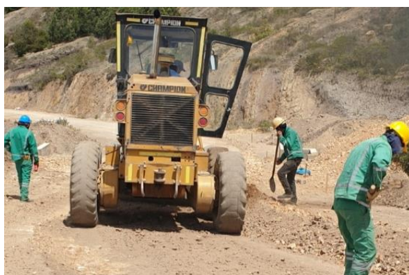
Figura 34. Nivelación del terreno.
