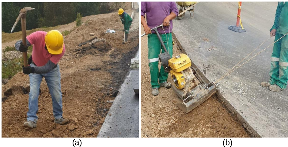
Figura 19. Excavación y afirmado de cunetas.
