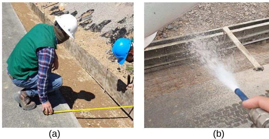
Figura 46. Verificación de los parámetros de diseño de cunetas.
