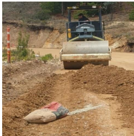
Figura 36. Estabilización del terreno.
