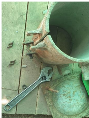
Figura 27. Mantenimiento de camisas.
