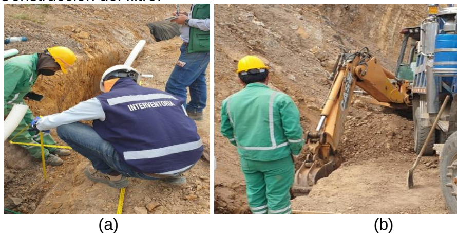
Figura 21. Construcción del filtro.
