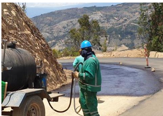
Figura 37. Riego de imprimación.
