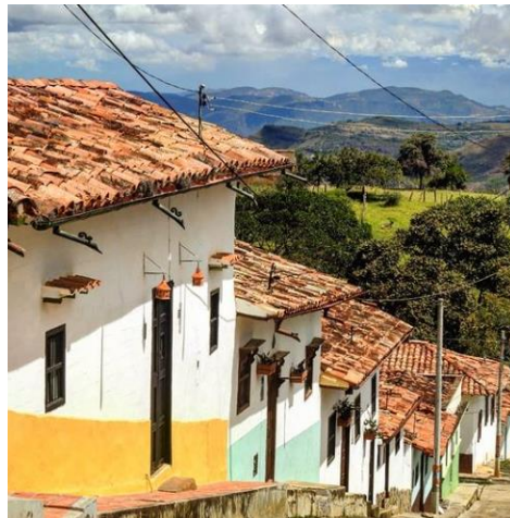
Figura 41. Fachadas de viviendas y topografía
