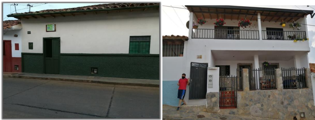
Figura 39. Fotografías de las vías perimetrales del lote
