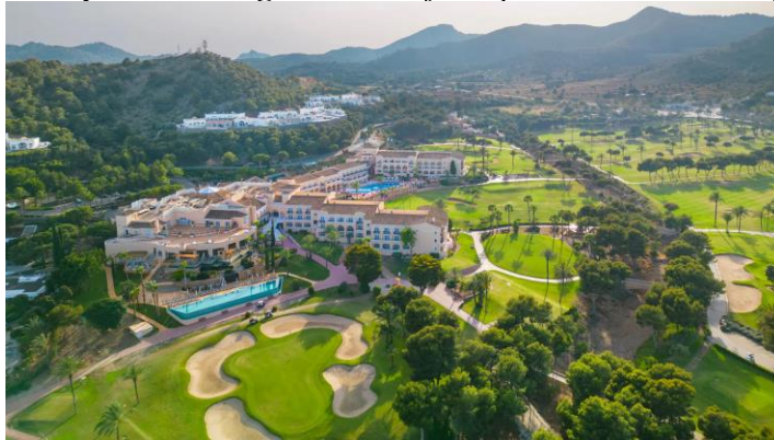
Figura 10. Hotel Grand Hyatt La Manga Club Golf & Spa - Vista aérea edificios del hotel
