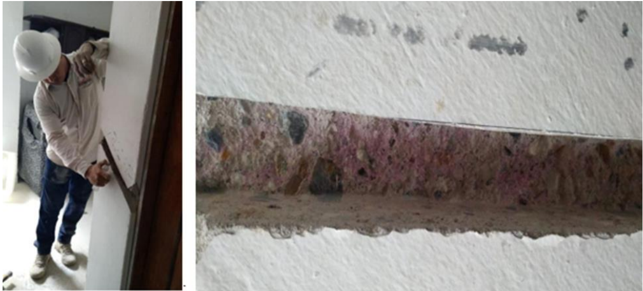
Ilustración 27 - Procedimiento de ensayo de carbonatación. Fuente: ESSUING, 2024
