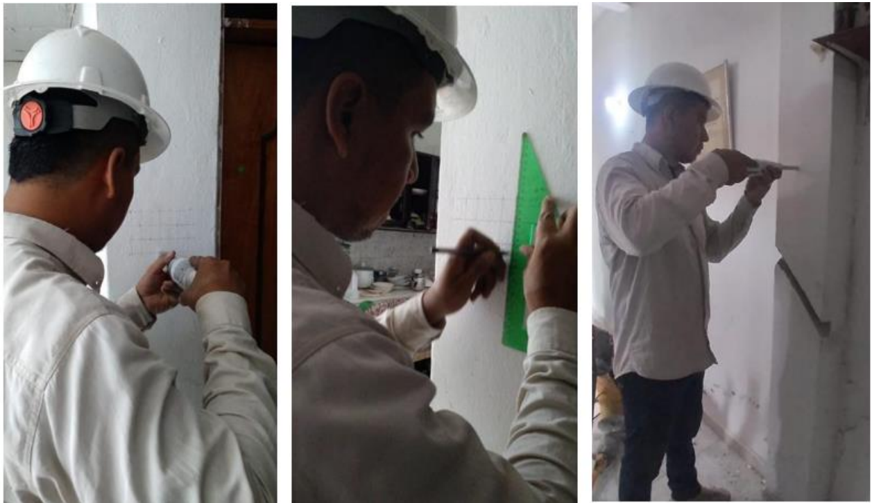
Ilustración 25 - Toma de muestra de esclerometría en elementos estructurales. Fuente: ESSUING, 2024
