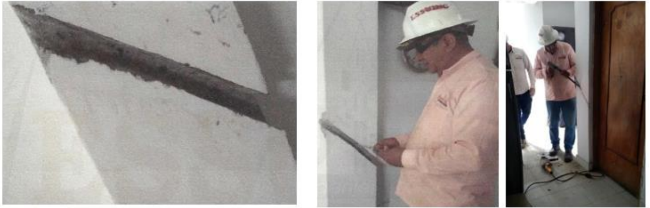
Ilustración 24 - Auscultaciones en elementos estructurales. Fuente: ESSUING, 2024
