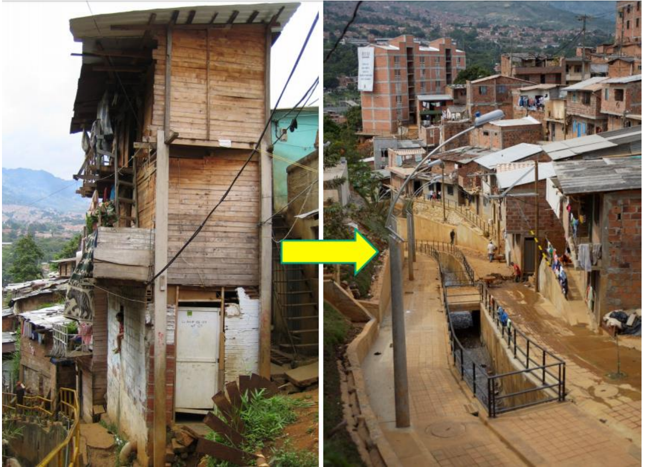
Figura 27 Antes y Después Quebrada Juan Bobo. Adaptado de Empresa de Desarrollo Urbano
