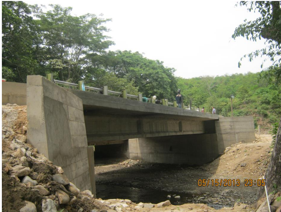
Foto No. 2 Puente Santa Inés PR9+000 carretera Agua Clara – Ocaña Fuente: Propia VIGA CAJÓN
