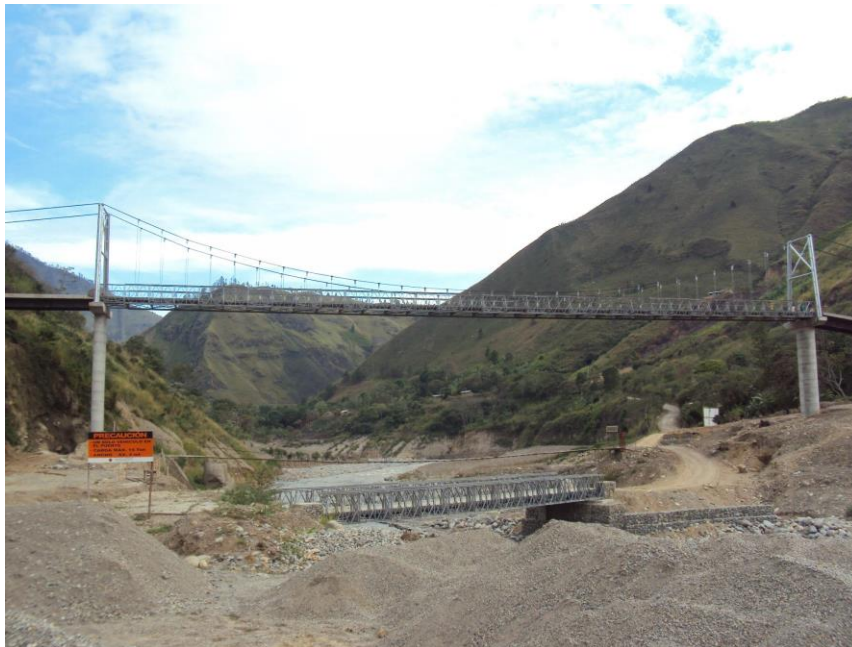
Foto No. 8 Puente Juntas rio Páez Cauca Fuente: Propia
