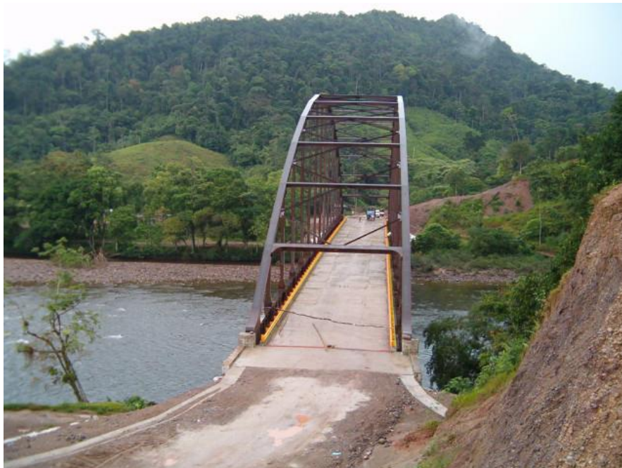
Foto No. 6 Puente San José de Fragua – Caquetá Fuente: Propia
