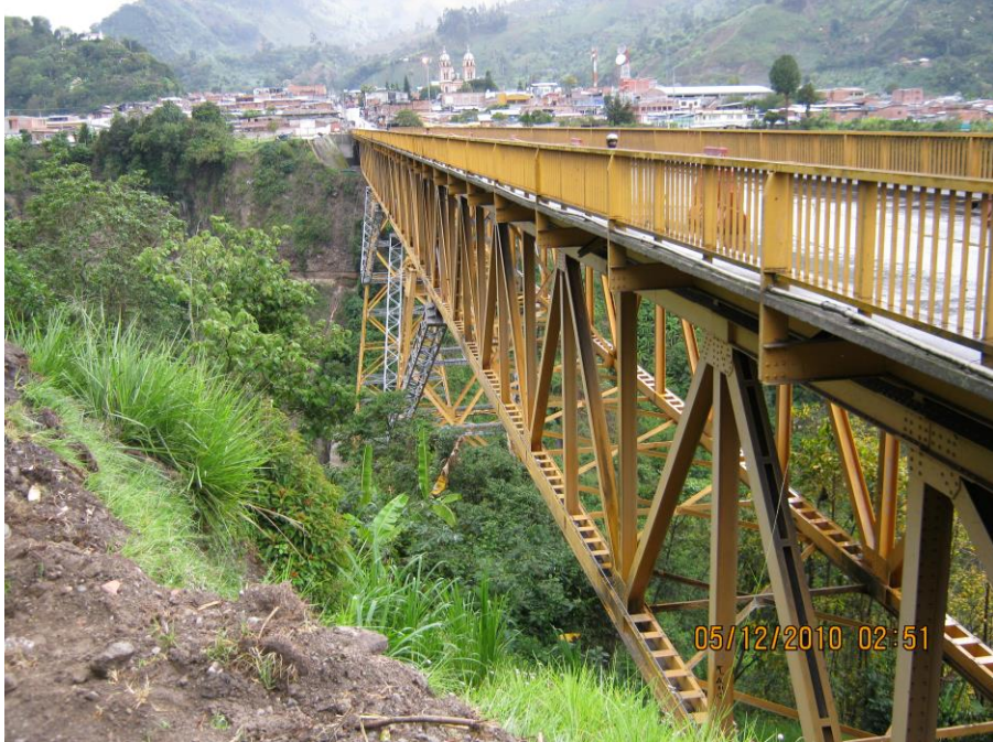
Foto No. 5 Puente Cajamarca Fuente: Propia
