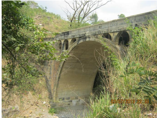
Foto No. 1 Puente carretera El Zulia – Gramalote (14)
