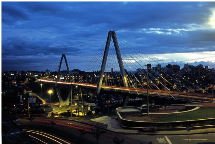
Foto No. 11 Viaducto Pereira – Dosquebradas
