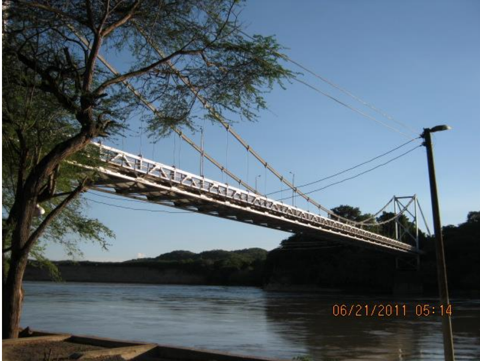
Foto No. 9 Puente Cambao sobre el rio Magdalena Fuente Propia
