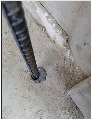
Ilustración 3. Anclajes mampostería
