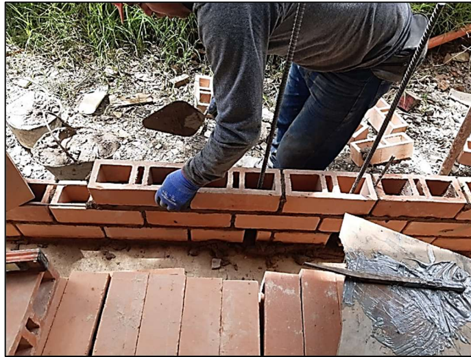
Ilustración 4. Refuerzo con grafiles 5 mm
