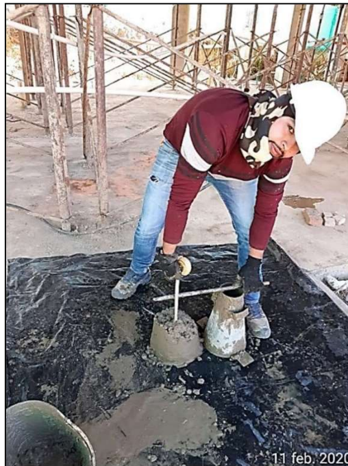
Imagen 2. Prueba de asentamiento del concreto
