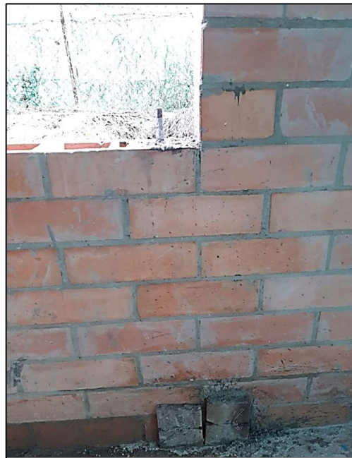
Ilustración 6. Celda de limpieza, mampostería
