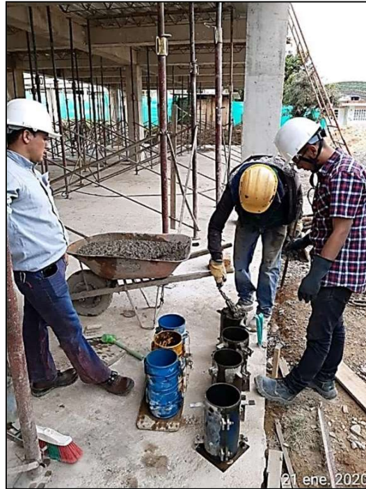
Imagen 1. Extracción de muestras cilíndricas de concreto
