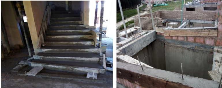
Ilustración 25. Fundida de escalera y vigas cinta.
