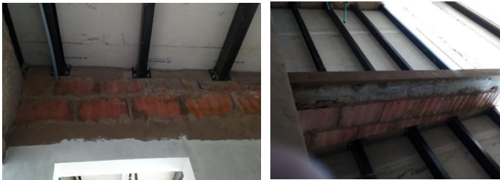
Ilustración 18. Instalación de perfilera de cubierta.
