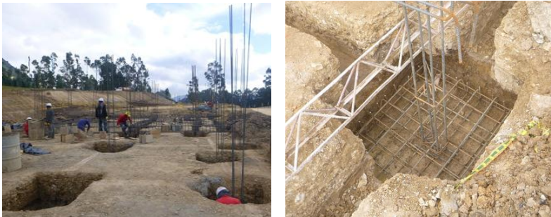
Ilustración 5. Armado de zapatas.
