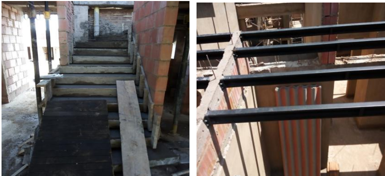
Ilustración 28. Remates en pañete interno y Mampostería fachada.
