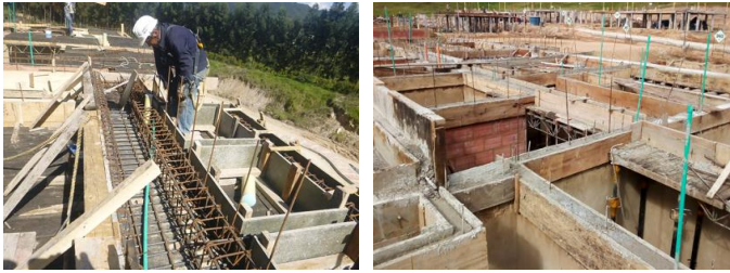
Ilustración 15. Armado y fundida de viga de cierre.
