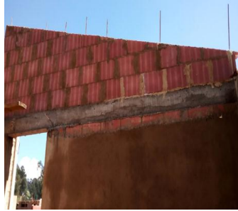
Ilustración 34. Mampostería de culatas.
