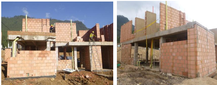
Ilustración 11. Mampostería interna.
