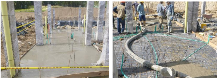
Ilustración 9. Armado y fundida de placa de contrapiso.
