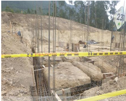
Ilustración 6. Armado de viga de cimentación.
