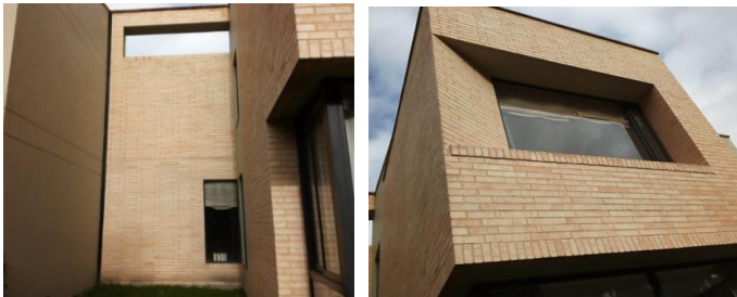
Ilustración 12. Mampostería de fachada.
