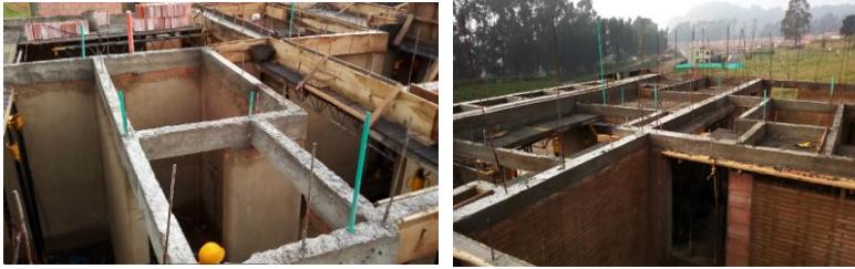
Ilustración 23. Dovelas en viga de cierre.
