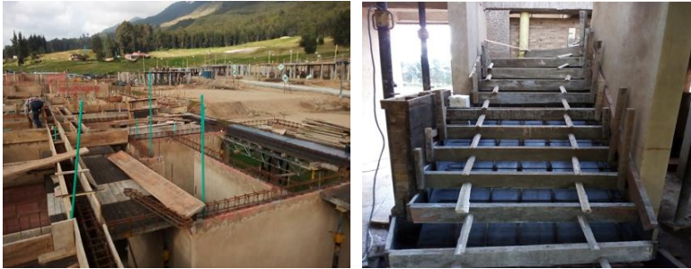
Ilustración 24. Encofre de viga de cierre y armado de escalera.
