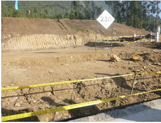
Ilustración 4. Replanteo de cimentación.
