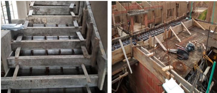
Ilustración 30. Revisión de armado de acero de viga de cierre y escalera.
