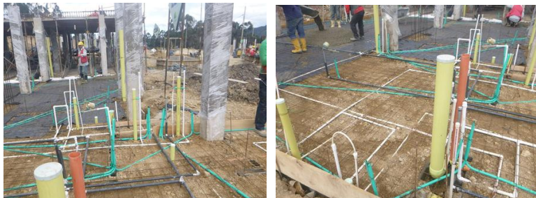
Ilustración 8. Prolongación de redes hidrosanitarias.
