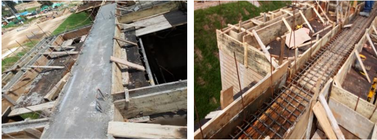
Ilustración 22. Viga de cierre.
