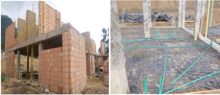
Ilustración 20. Instalación de teja cartabón.
