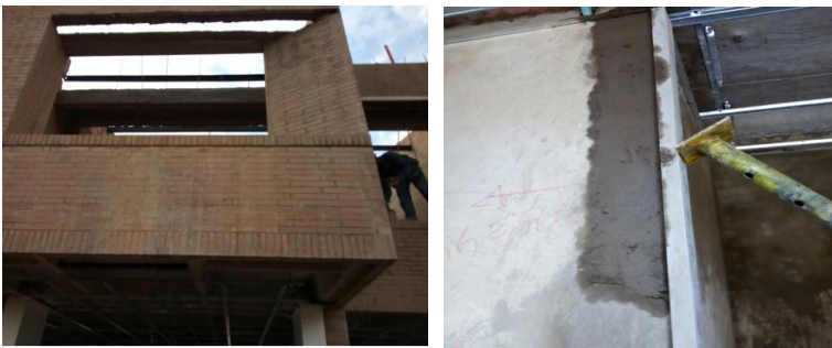
Ilustración 27. Remates en pañete interno y Mampostería fachada.
