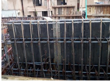
Ilustración 32. Revisión armado viga dintel.
