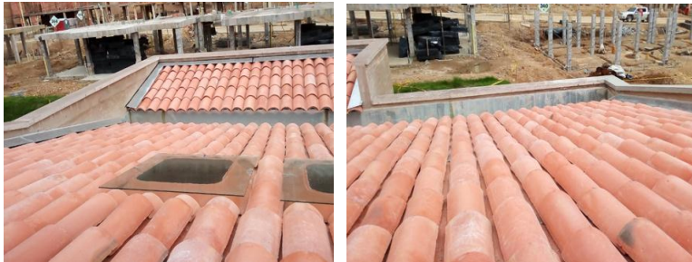
Ilustración 19. Instalación de teja cartabón.
