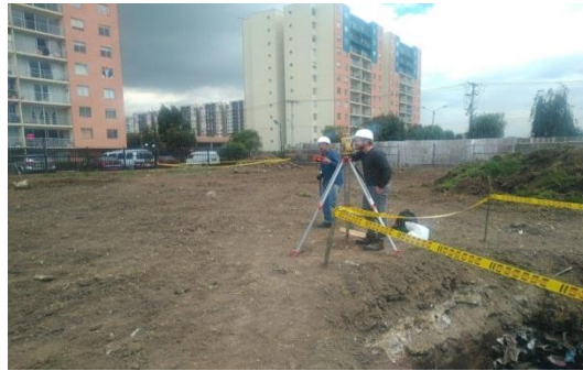
Figura 77. Comision de topografia control de inspecciones/Fuente comision de topografia
