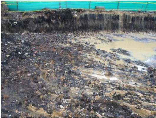
Figura 21 y 22 Perforacion de inspección filtracio agua/Fuente propia
