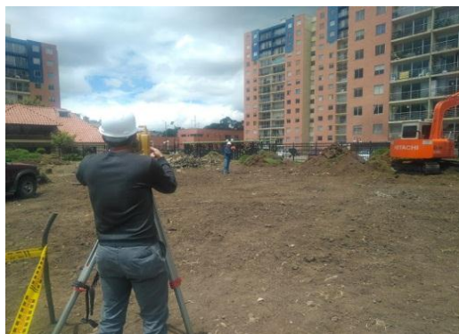
Figura 2 control topografico niveles/Fuente propia
