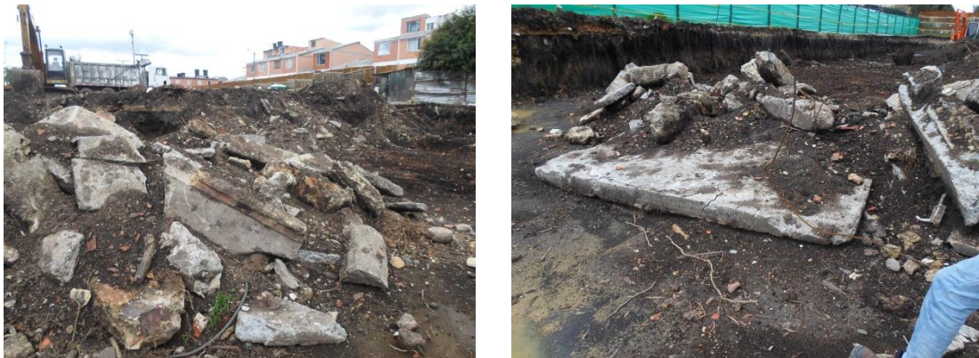
Figura 64.Placas-vigas en concreto enterras/Fuente propia
