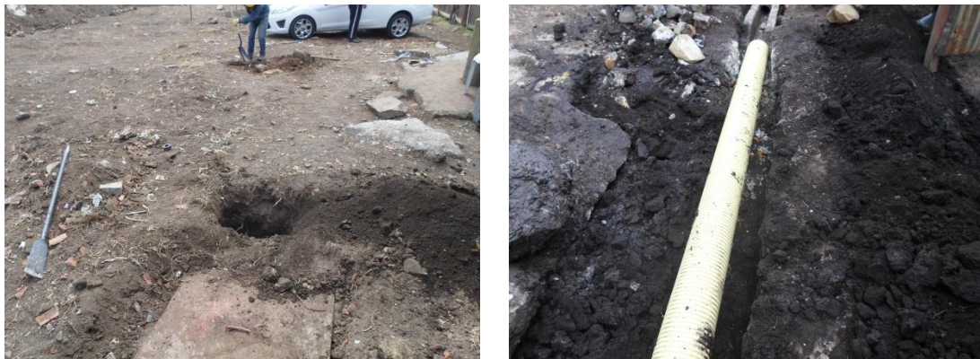
Figura 67.Perforaciones de inspeccion/Fuente propia
