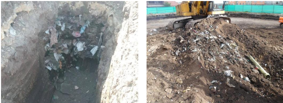
Figura 19 y 20 Perforación de inspección material inorgánico/Fuente propia
