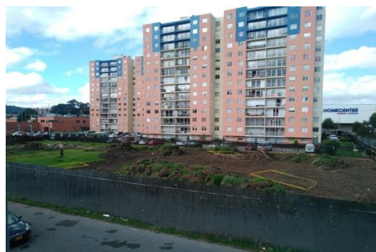
Figura 4 Demarcacion perforaciones/Fuente propia
