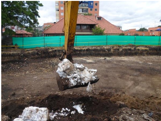
Figura 70. Inspección 3-icopor enterrado
