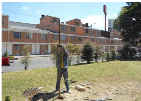
Figura 50. Sondeos del terreno/Fuente Propia
