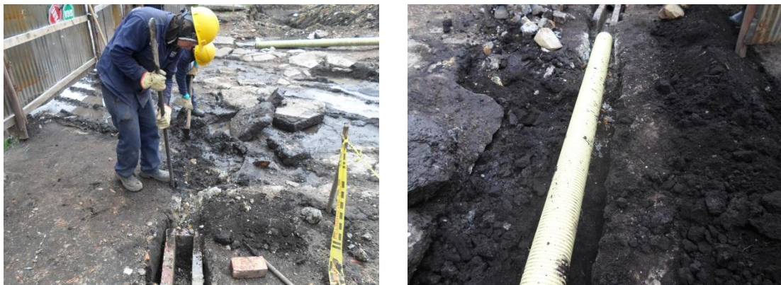
Figura 60. Redes encontradas en excavación/Fuente propia
