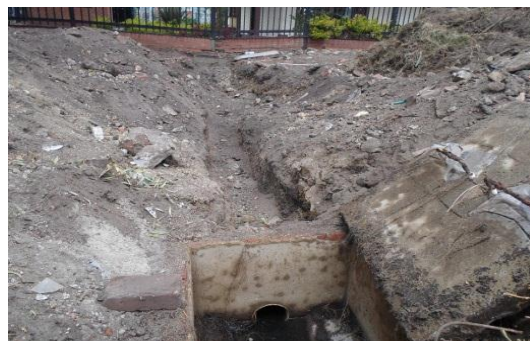
Figuras 58.Redes encontradas en excavacion/Fuente propia
