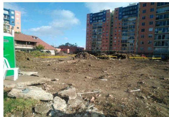
Figura 3 control excavaciones/Fuente propia
