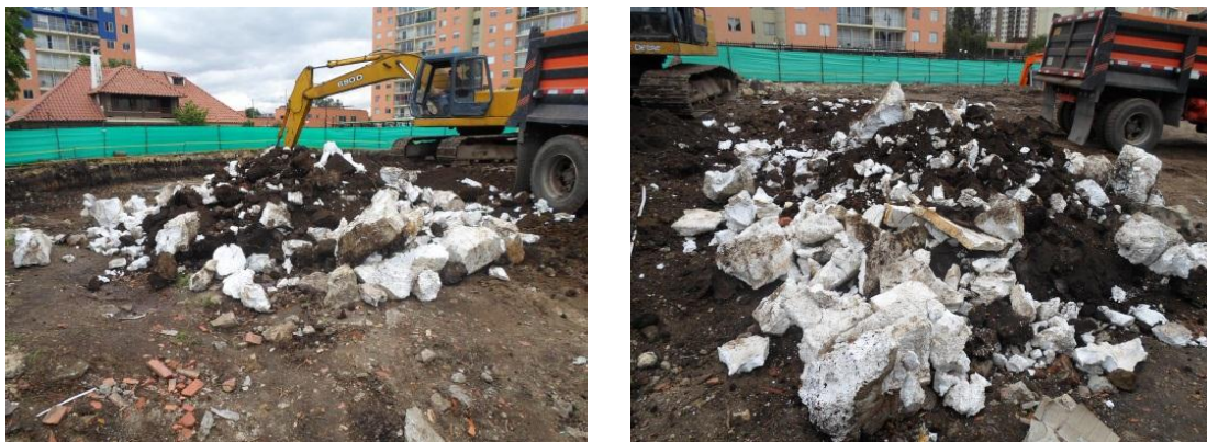
Figura 63.Excavacion de inspección icopor enterrado/Fuente propia
