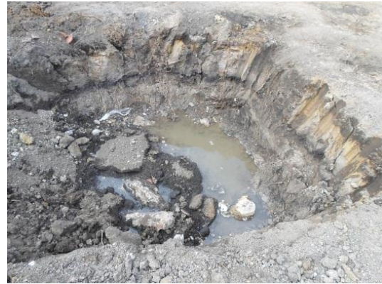
Figura 21 y 22 Perforacion de inspección filtracio agua/Fuente propia
