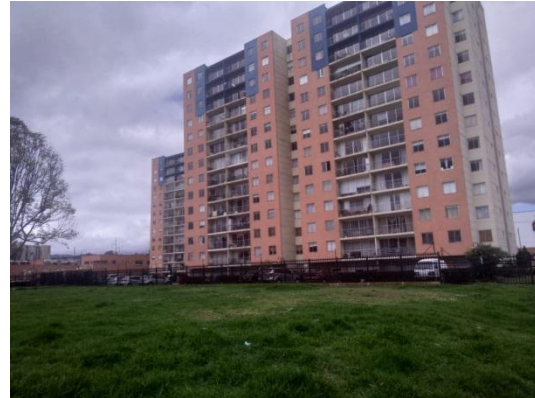
Figura 11. Vivienda costado sur/Fuente propia
