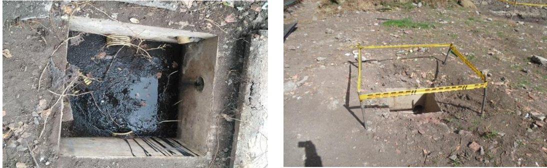
Figura 59. Redes encontradas en excavación/Fuente propia
