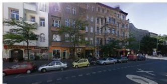
Vista a primer nivel en la calle Schlesisches.
