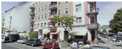
Vista a primer nivel cruce de calle Schlesisches y Curvystraße.
