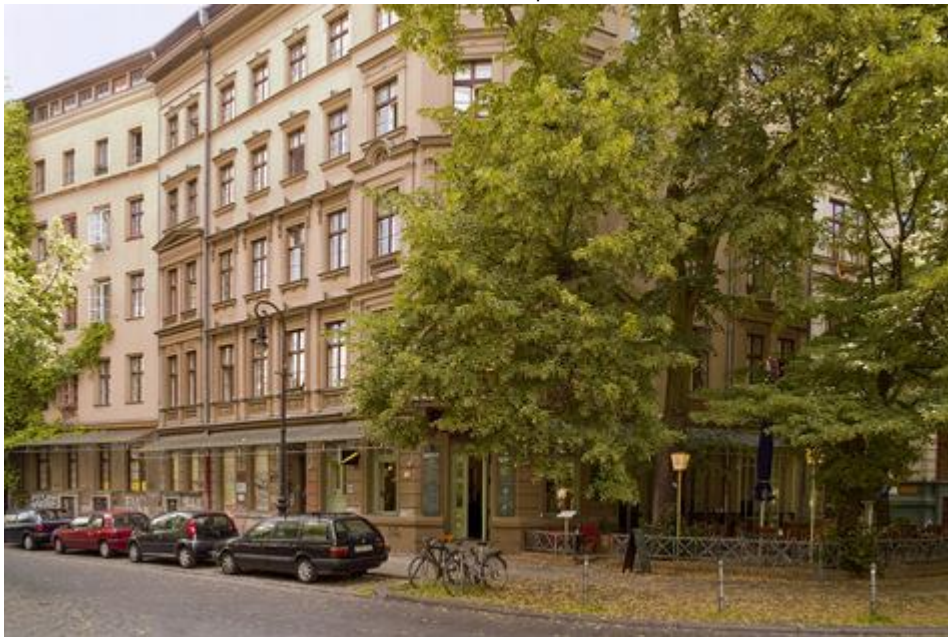
FIG 43. Vista de WP Wassertorplatz desde la calle.
