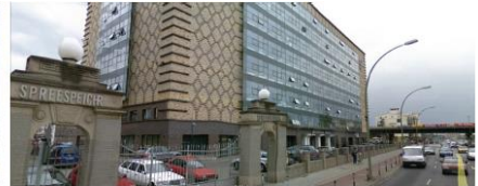
Vista de la calle Stralauer al norte del Río.
