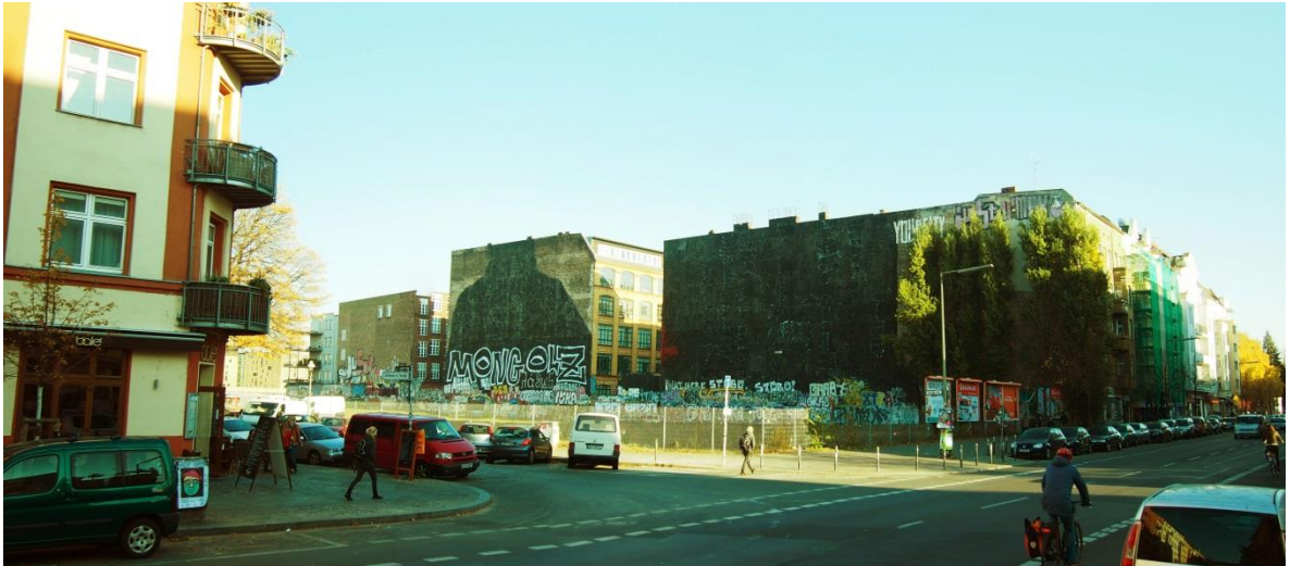
FIG 38. Vista hacia el lote desde la esquina opuesta en la Calle Schlesisches.
