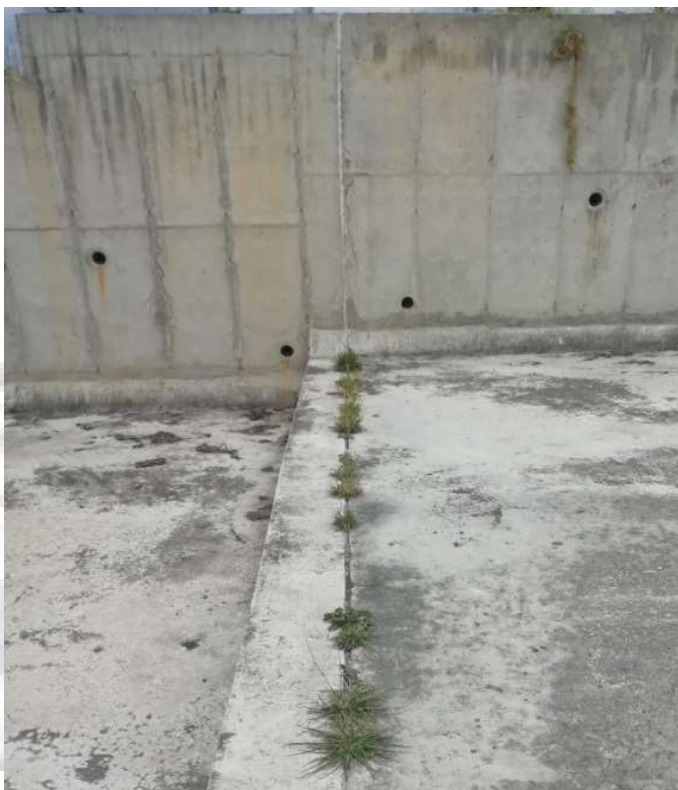
Fotografía. 129. Afloramiento de vegetación a través de la junta.
