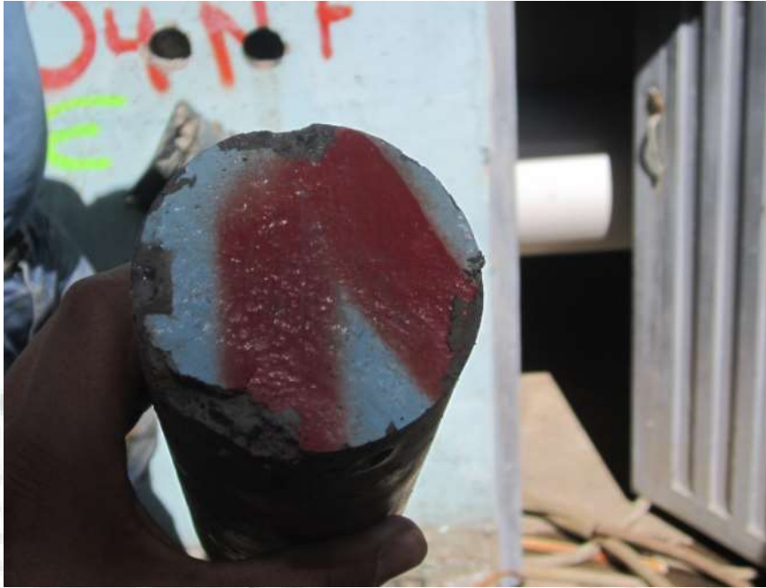
Fotografía. 145. Núcleo extraído caseta de máquinas.
