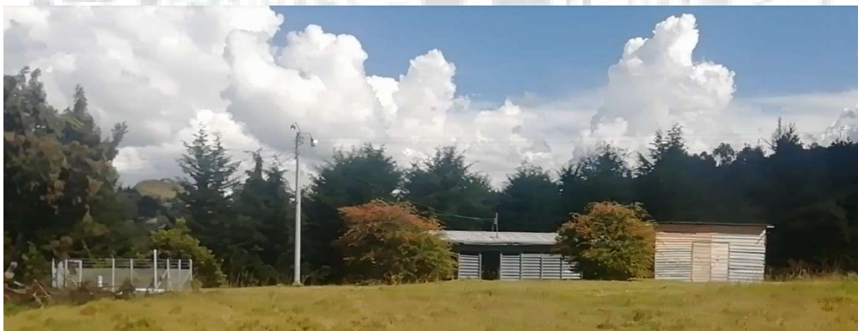
Fotografía. 106. Vista general del campamento de construcción.
