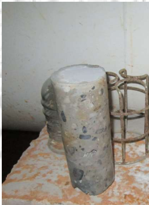
Fotografía. 141. Extracción núcleo en túnel de descarga. Fuente: Consorcio Embalses CAR, 2020.
