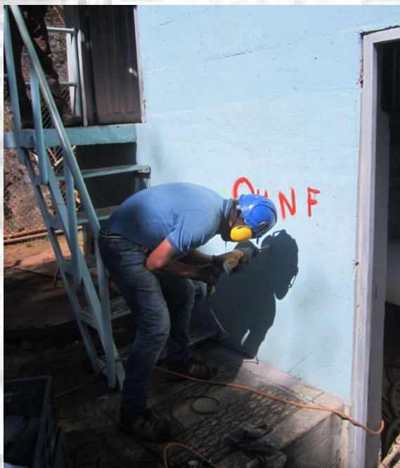
Fotografía. 144. Extracción núcleo en muro caseta de máquinas. Fuente: Consorcio Embalses CAR, 2020.
