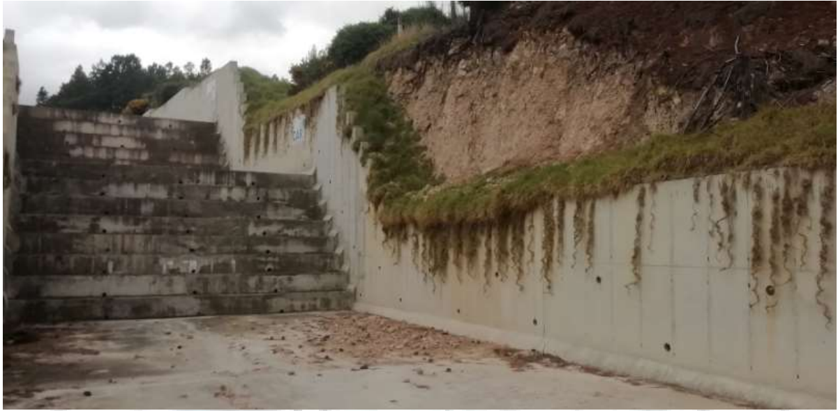
Fotografía. 130. Inestabilidad del talud del margen izquierdo del vertedero. Fuente: Consorcio Embalses CAR, 2020.
