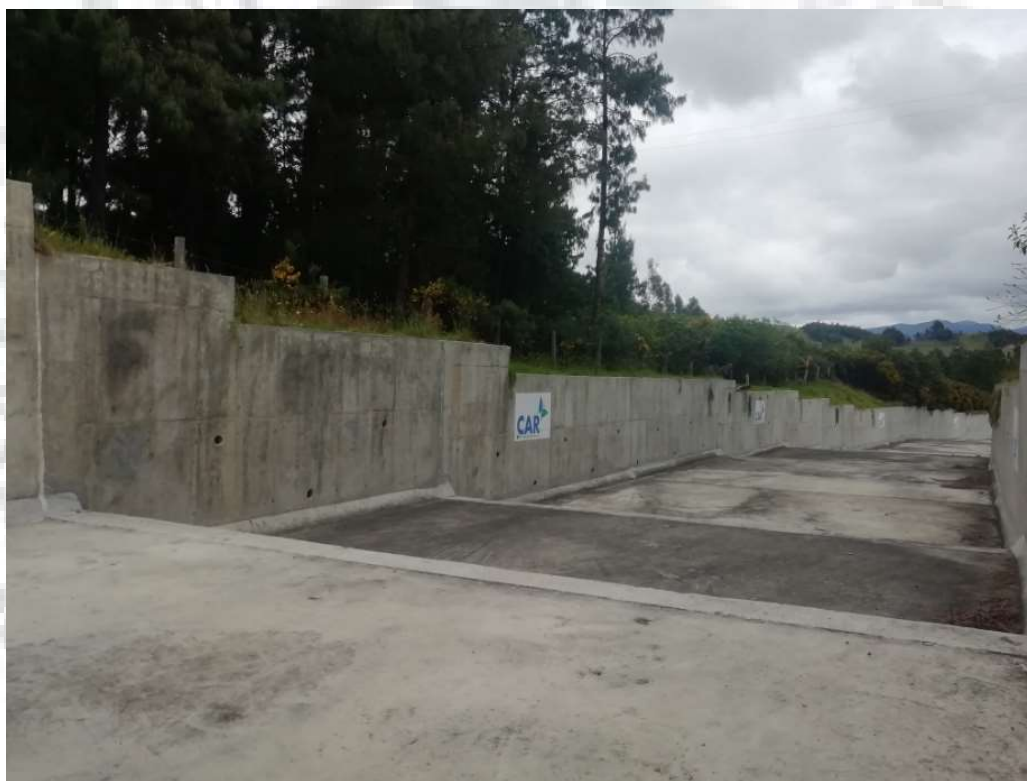
Fotografía. 126. Vista longitudinal del vertedero de excesos (Aguas arriba). Fuente: Consorcio Embalses CAR, 2020.
