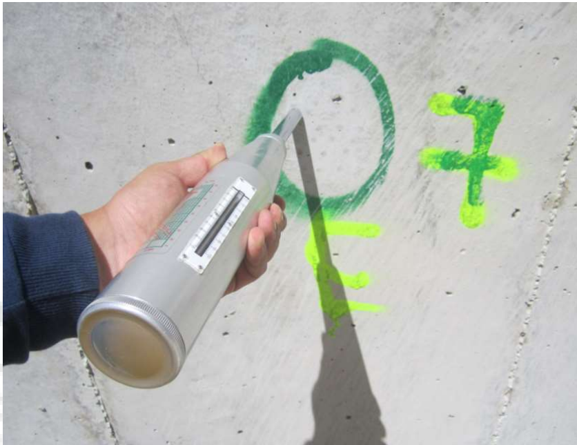
Fotografía. 134. Esclerometría en muro margen izquierda vertedero de excesos. Fuente: Consorcio Embalses CAR, 2020.
