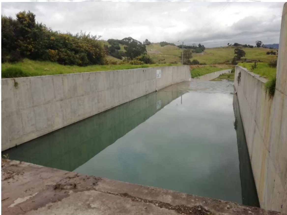
Fotografía. 132. Tanque de amortiguación, disipación del flujo.
