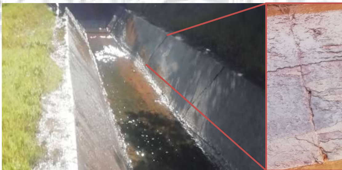
Fotografía. 124. Vista general junta transversal.
