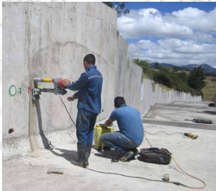
Fotografía. 135. Extracción núcleo en muro margen izquierda vertedero de excesos. Fuente: Consorcio Embalses CAR, 2020.
