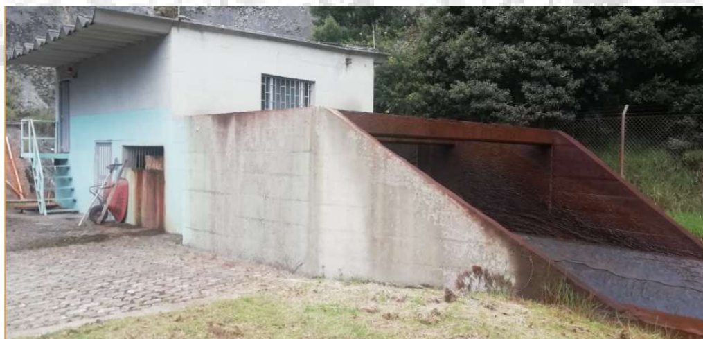
Fotografía. 122. Estado actual de la caseta de control.
