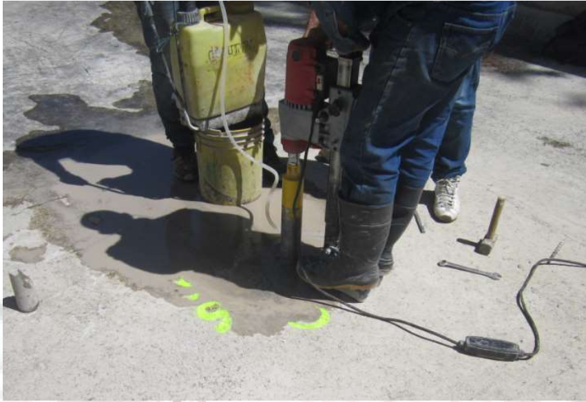
Fotografía. 136. Extracción núcleo en losa de fondo vertedero de excesos. Fuente: Consorcio Embalses CAR, 2020.
