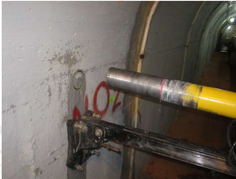
Fotografía. 140. Extracción núcleo en muro túnel de descarga. Fuente: Consorcio Embalses CAR, 2020.
