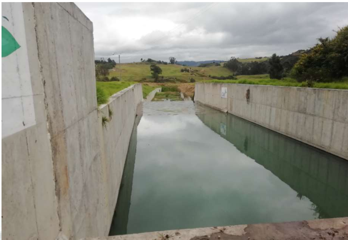
Fotografía. 133. Tanque de amortiguación, disipación del flujo.
