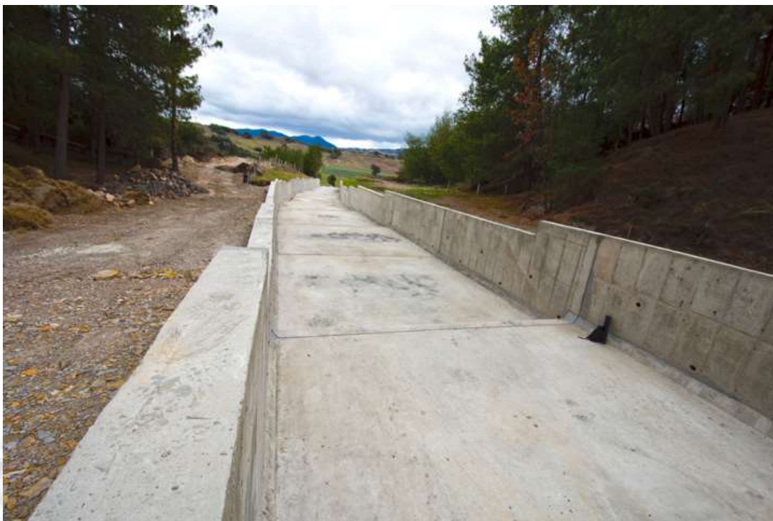
Fotografía. 107. Construcción vertedero de excesos.
