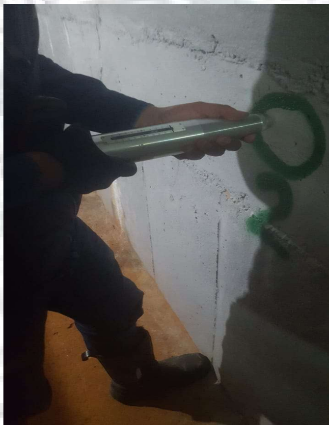
Fotografía. 139. Esclerometría en muro túnel de descarga. Fuente: Consorcio Embalses CAR, 2020.
