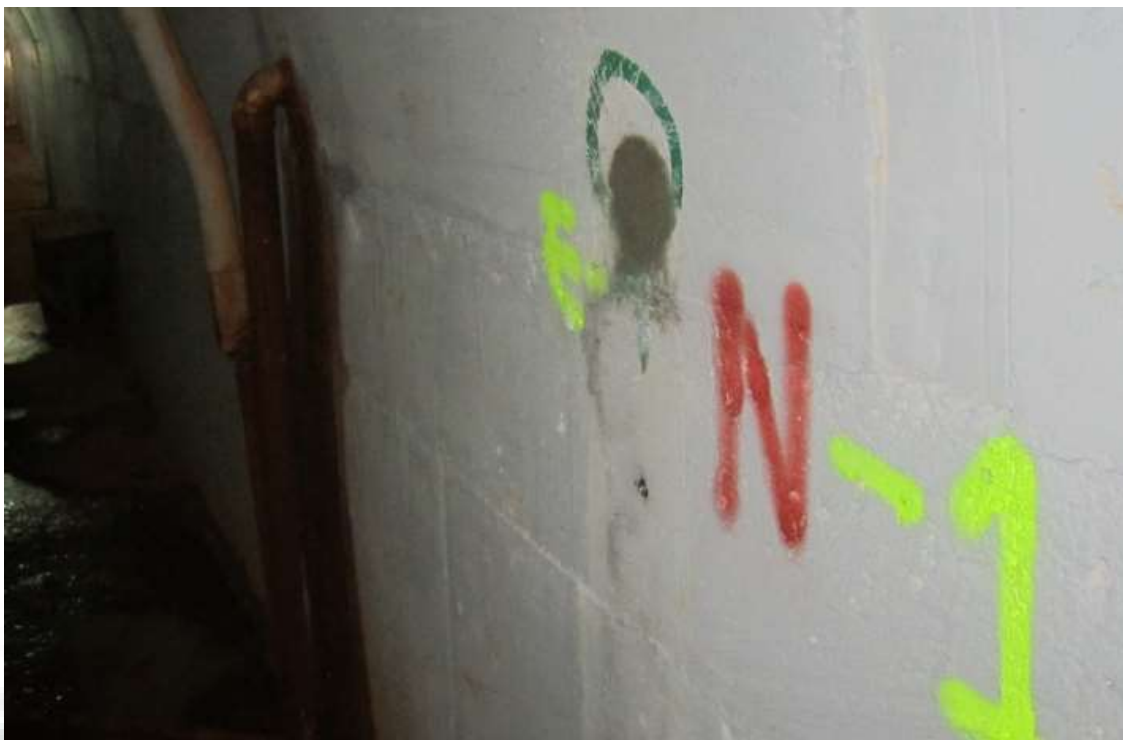
Fotografía. 142. Reparación típica de los núcleos extraídos.
