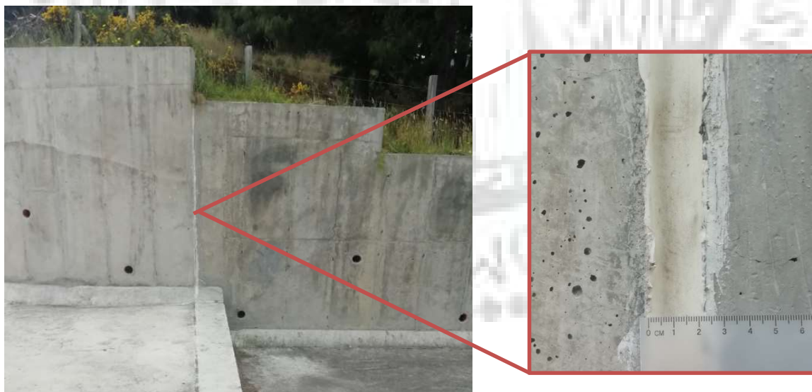
Fotografía. 127. Vista general junta transversal.
