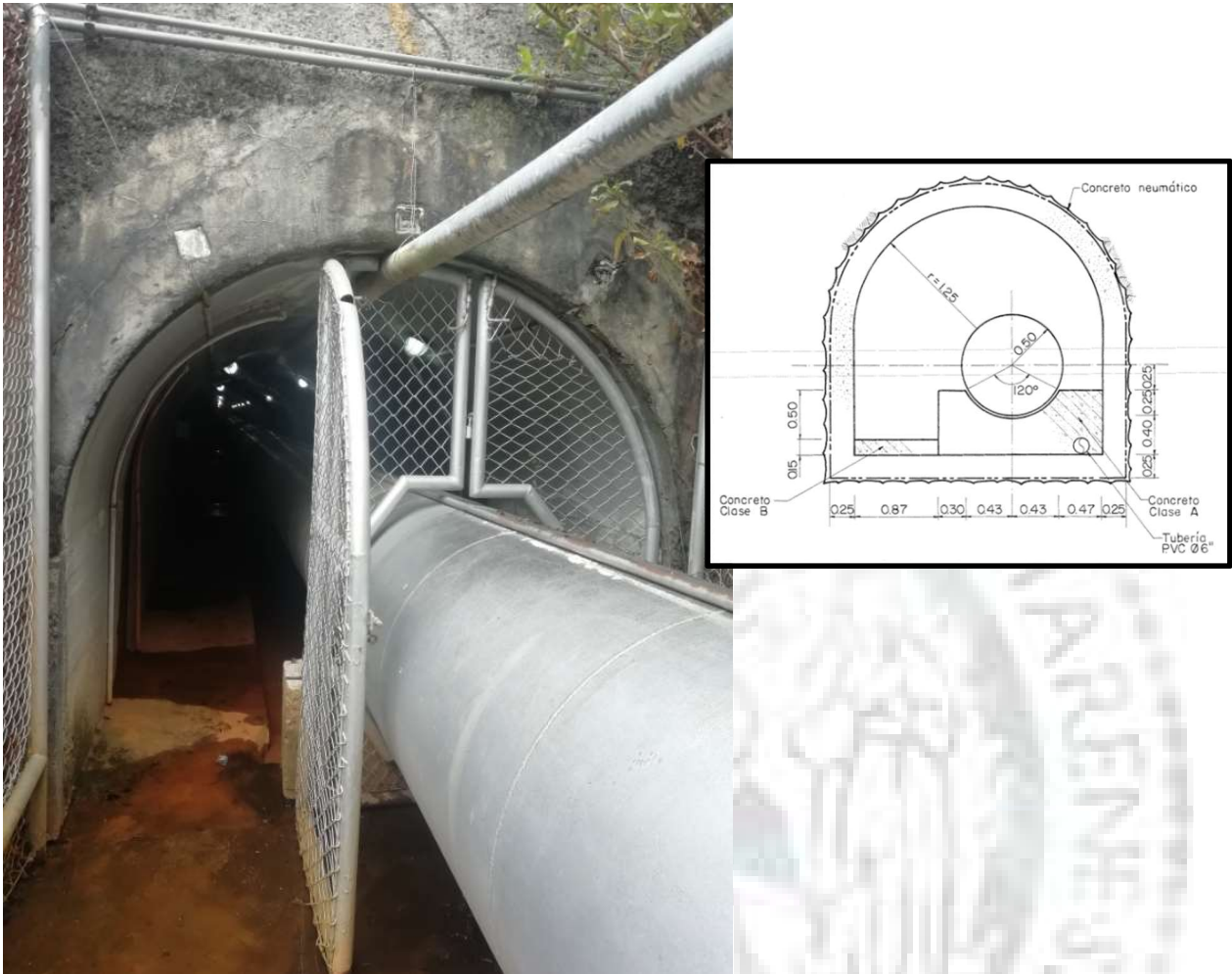
Fotografía. 117. Vista general portal de salida del túnel de descarga.
