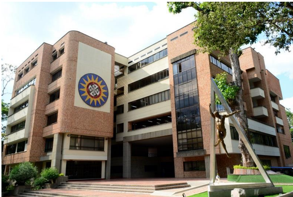
Figura 6: Edificio Fray Angélico de la sede de Floridablanca. Donde actualmente está ubicado el departamento de arquitectura de la USTA. Imagen tomada de la página web oficial USTA.
