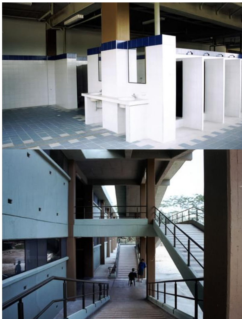
Figura 13. Alojamiento de infantes Coveñas, baños y circulación, 2013
