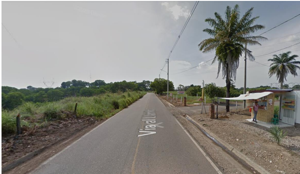
Figura 32. Estado actual vía El Llanito
