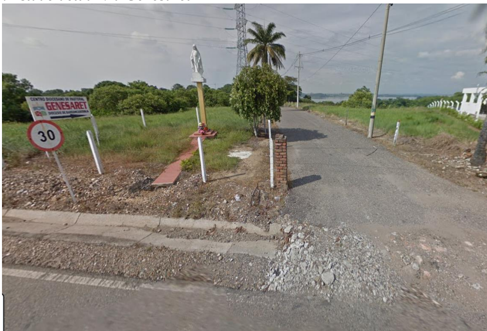
Figura 33. Estado actual vía Genesaret
