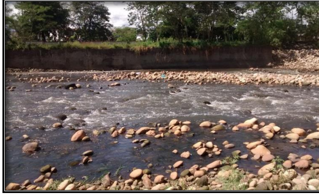
Figura 4-55 Estructura de contención Camino Ganadero. Fuente: SÁNCHEZ ARAGÓN, J.S, Agosto de 2017.
