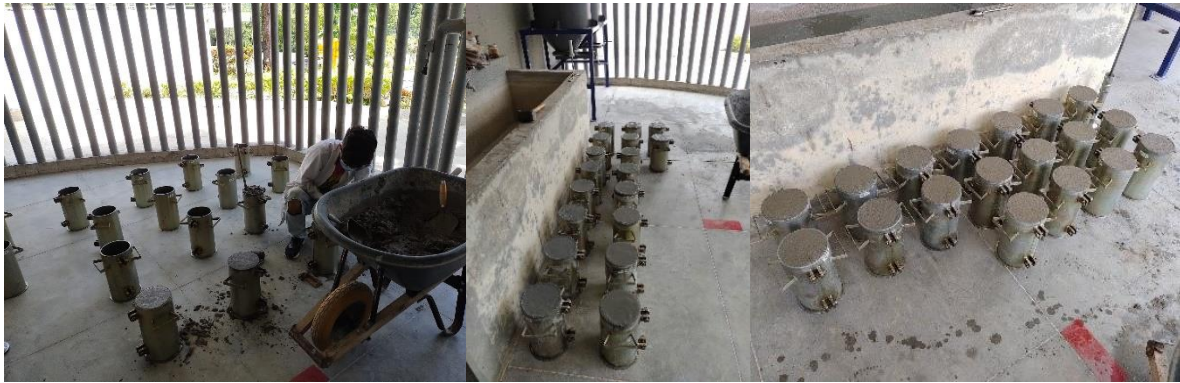
Figura 33. Vaciado de la mezcla, concreto CAR y CAP, respectivamente
