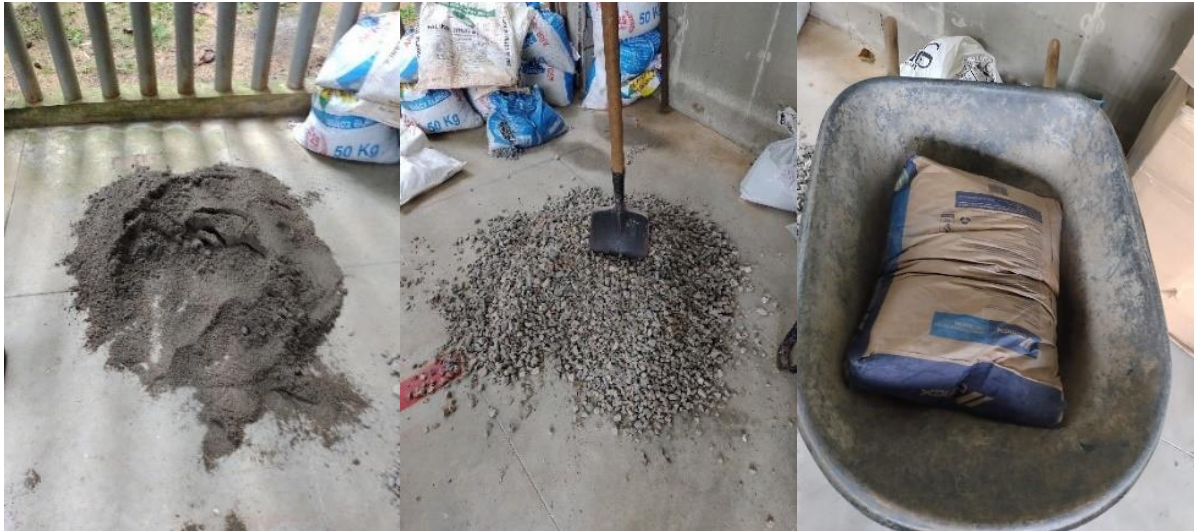
Figura 24. Preparación de arena, grava y cemento, concreto CAR
