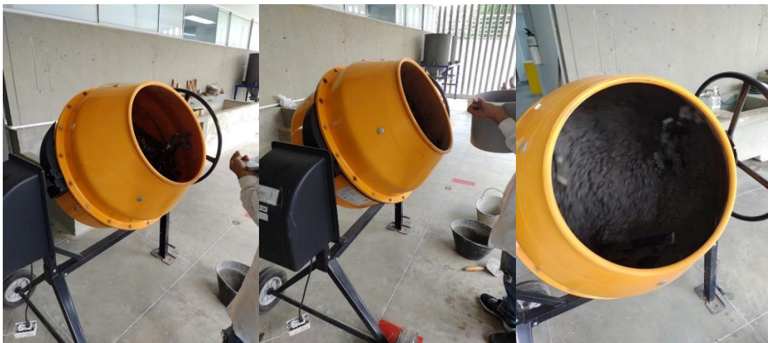
Figura 29. Mezclado de los materiales, concreto CAR
