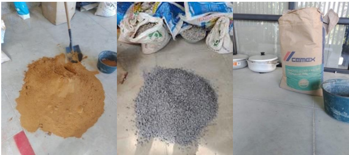
Figura 25. Preparación de arena, grava y cemento, concreto CAP
