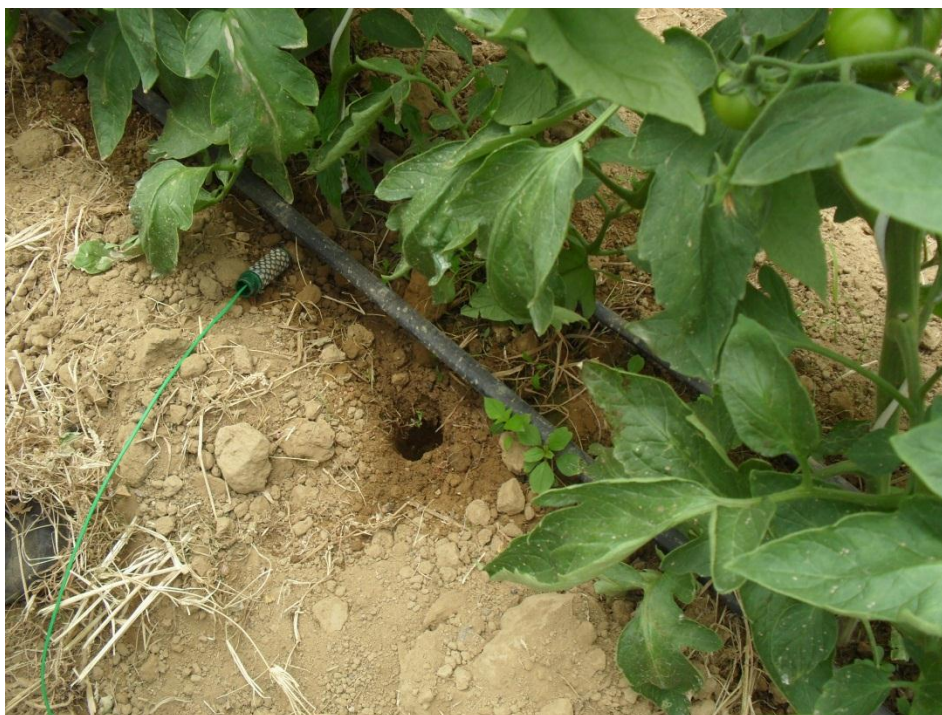
Figura 64. Instalación sensor de humedad de suelo
