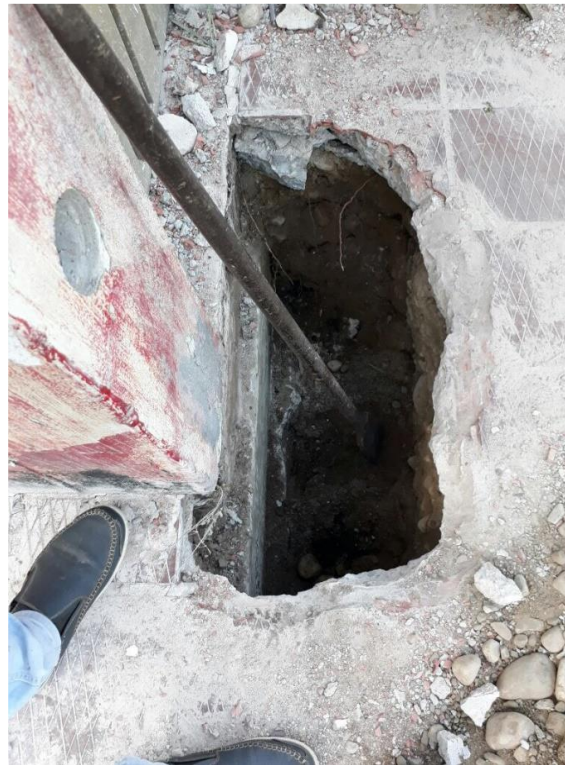
Figura 53. Inspección de Zapatas. Fuente: Fotografías del autor.
