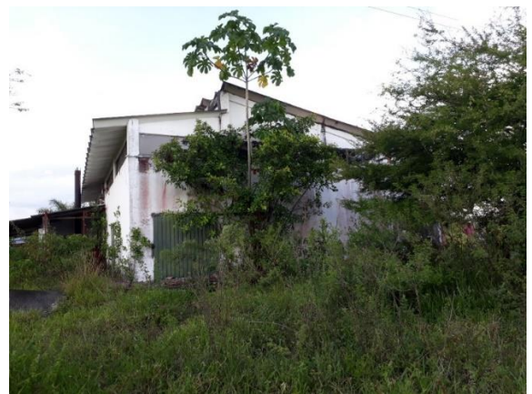
Figura 9. Fachada Sur. Fuente: fotografías del autor.
