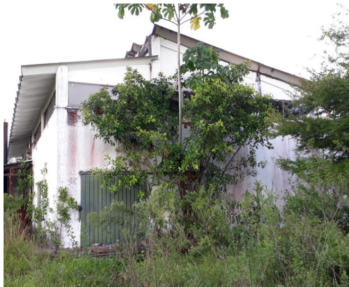
Figura 56. Estado de la edificación en el mes de diciembre de 2017 - fachada sur. Fuente: Fotografías del autor.
