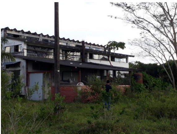
Figura 8. Fachada Oriente. Fuente: fotografías del autor.
