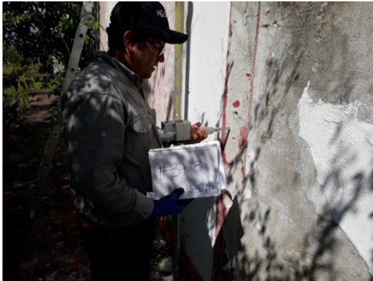
Figura 45. Prueba de esclerómetro Punto No 378.
