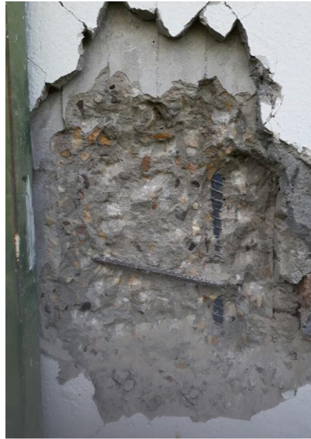
Figura 51. Revisión de aceros en columnas. Fuente: Fotografías del autor.
