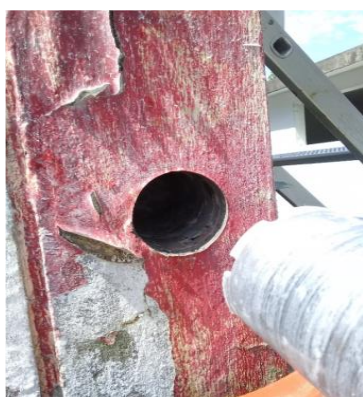
Figura 41. Elementos con perforación de extracción de núcleos. Fuente: Fotografías del autor.
