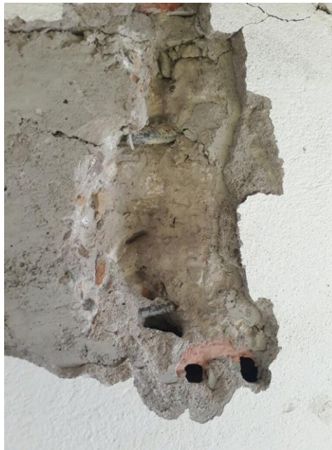
Figura 52. Revisión de aceros en vigas. Fuente: Fotografías del autor.
