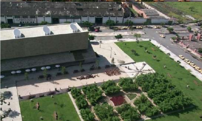
Figura 7 Parque de los Pies Descalzos y bodega industrial.
