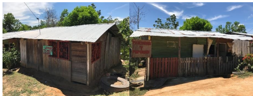
Figura 67. Vivienda en madera.
