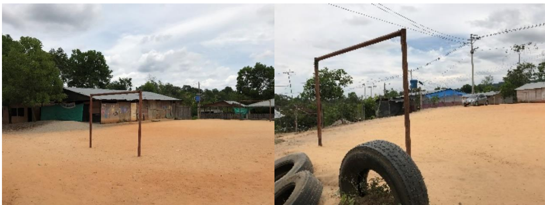
Figura 89. Escuela. Vista general.
