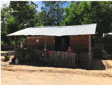
Figura 51. Vivienda en madera.
