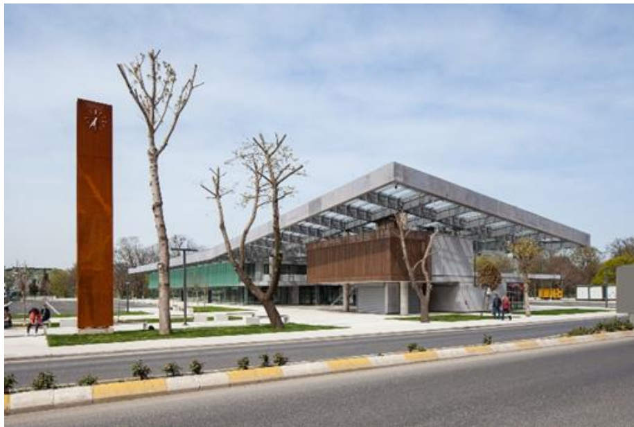
Figura 29. Fachada de la estación de autobuses de Lüleburgaz.
