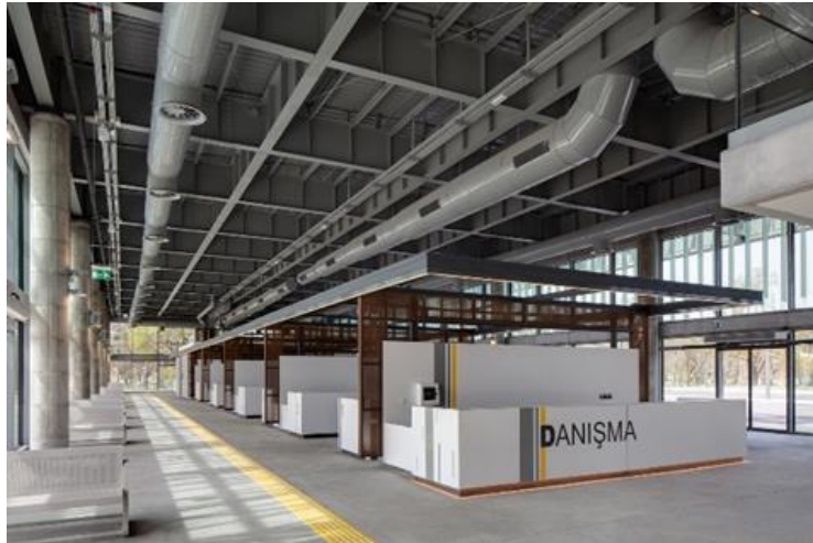
Figura 37. Vista interior de la estación de buses de Lüleburgaz.
