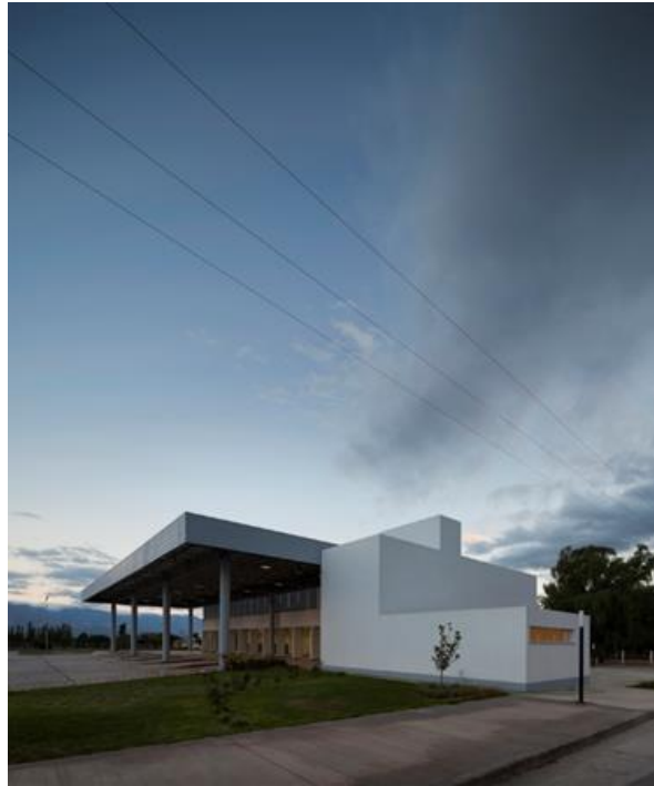
Figura 45. Vista exterior del Terminal de Omnibus de Cafayate.
