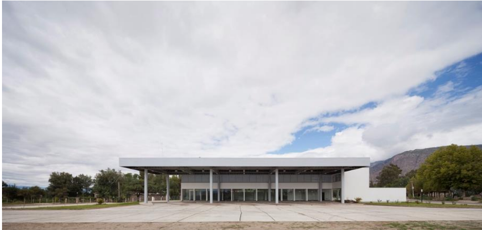
Figura 39. Fachada de Terminal de Omnibus de Cafayate.
