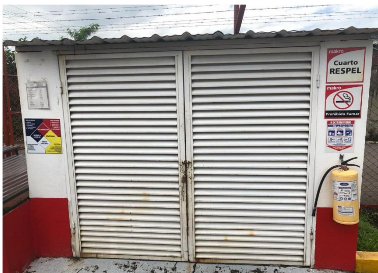
Ilustración 7 Cuarto de Respel, almacenamiento de residuos peligrosos
