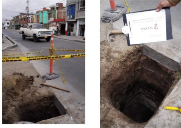
Fotografía 12. Apique A-2 (Carrera 7 sobre calle 29A) Fuente: de este estudio – 2016
