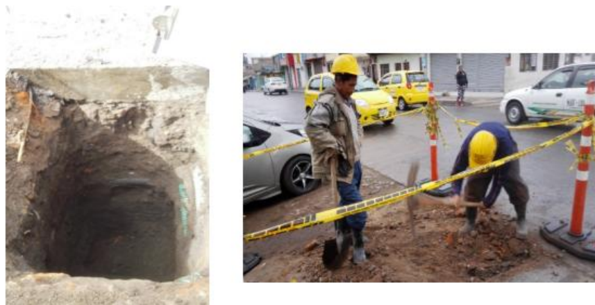
Fotografía 13. Apique A-3 (Carrera 7 sobre calle 30) Fuente: de este estudio – 2016.
