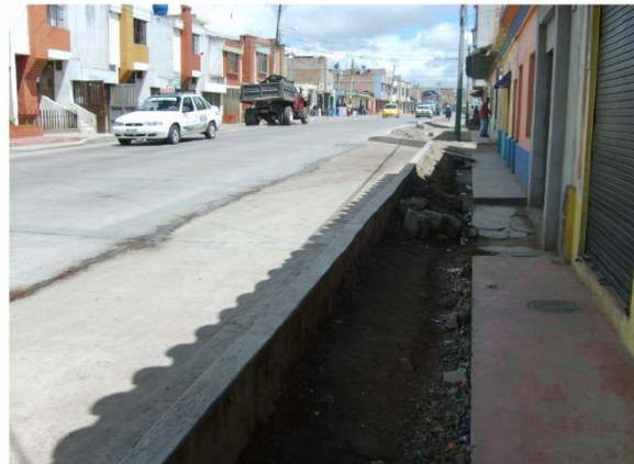
Fotografía 4. Ausencia de confinamiento año 2010. Fuente: Archivo Valorización Municipal de Ipiales – 2010.
