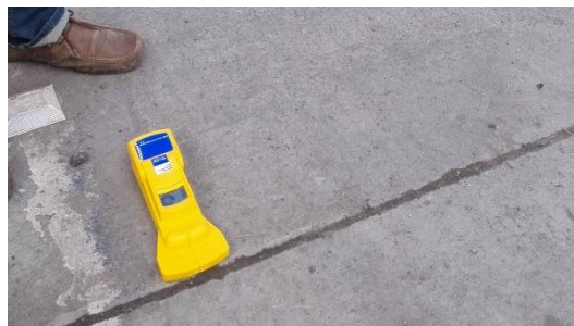
Fotografía 35. Mediciones para localización de refuerzo transversal Fuente: de este estudio – 2016
