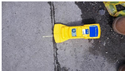
Fotografía 34. Mediciones para localización de refuerzo transversal Fuente: de este estudio – 2016
