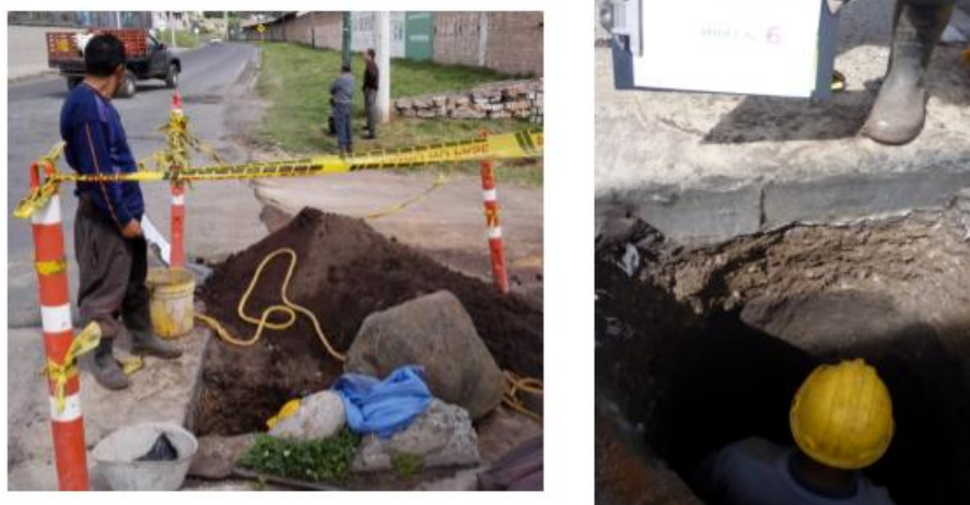
Fotografía 16. Apique A-6 (Carrera 7 sobre calle 34) Fuente: de este estudio – 2016.
