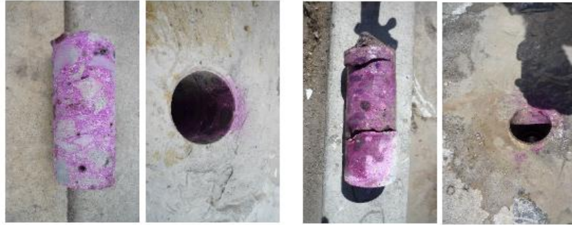
Fotografía 32. Núcleo 1, Núcleo 2 y Núcleo 3 (Carrera 7 entre calles 24 y 25) Fuente: de este estudio – 2016.
