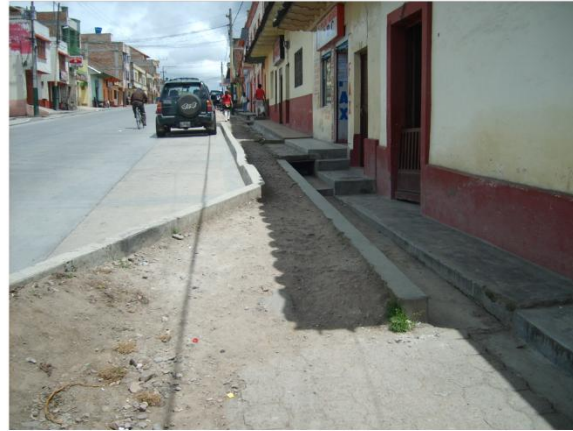
Fotografía 3. Ausencia de confinamiento año 2010. Fuente: Archivo Valorización Municipal de Ipiales – 2010.
