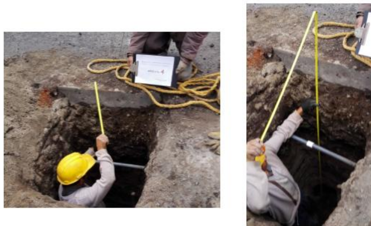
Fotografía 14. Apique A-4 (Carrera 7 sobre calle 31) Fuente: de este estudio – 2016.
