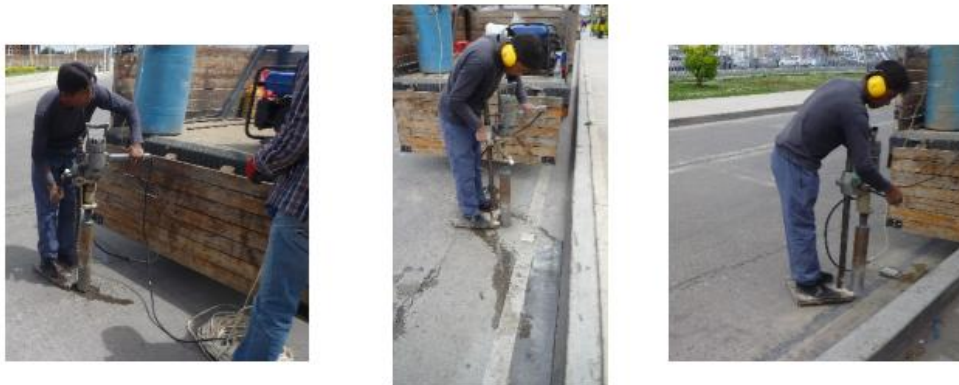
Fotografía 22. Núcleo 1, Núcleo 2 y Núcleo 3 (Carrera 7 entre calles 24 y 25) Fuente: de este estudio – 2016.
