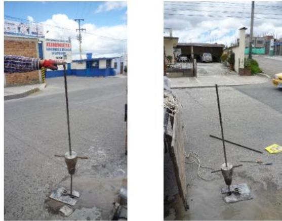
Fotografía 21. PDC 13 y PDC 14 (Carrera 7 entre calles 30 y 34) Fuente: de este estudio – 2016.
