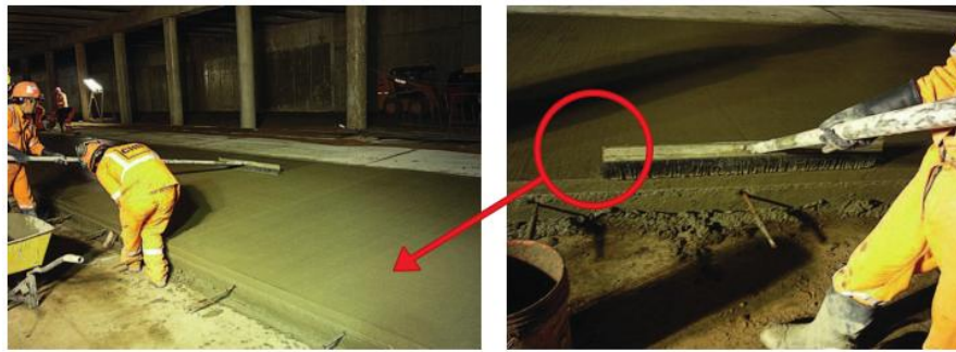
Fotografía 2. Macro texturizado con peine, sentido transversal Fuente: Blog Duravía
