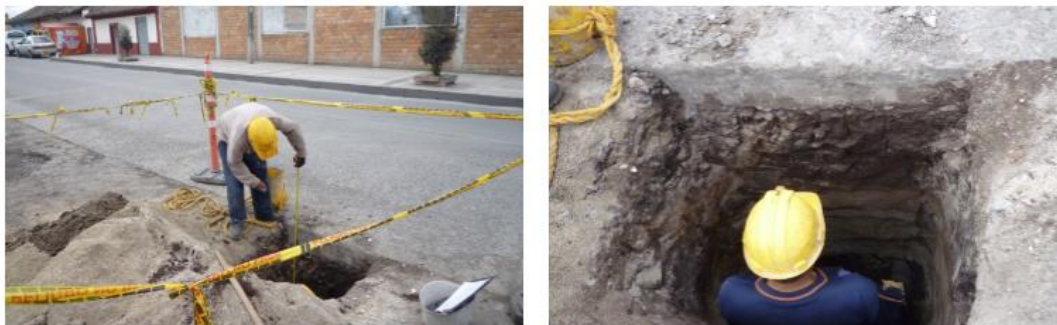
Fotografía 15. Apique A-5 (Carrera 7 sobre calle 32) Fuente: de este estudio – 2016.
