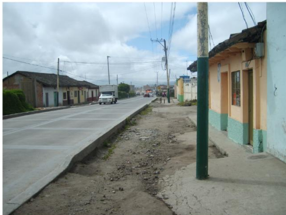
Fotografía 4. Ausencia de confinamiento año 2010. Fuente: Archivo Valorización Municipal de Ipiales – 2010.
