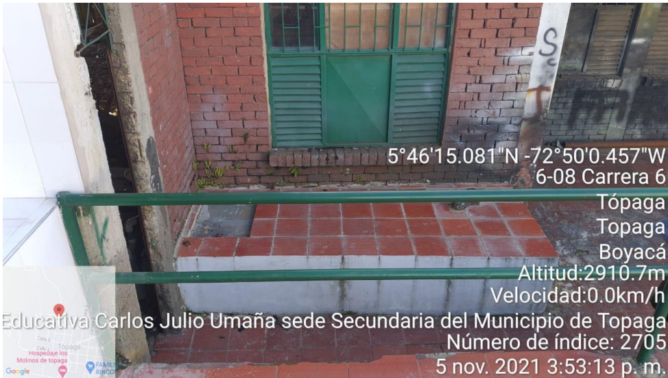
FOTOGRAFÍAS 5.4 - 5.10: MANTENIMIENTO Y REHABILITACION DE LA INSTITUCION EDUCATIVA CARLOS JULIO UMAÑA EN EL MUNICIPIO DE TOPAGA, SEDE SECUNDARIA (FOTOGRAFÍAS DILIGENCIA DE INSPECCIÓN).
