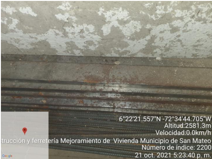
Fotografía 10. Evidencia de material barra corrugada de 1/2" Elaboración. Contraloría General de Boyacá
