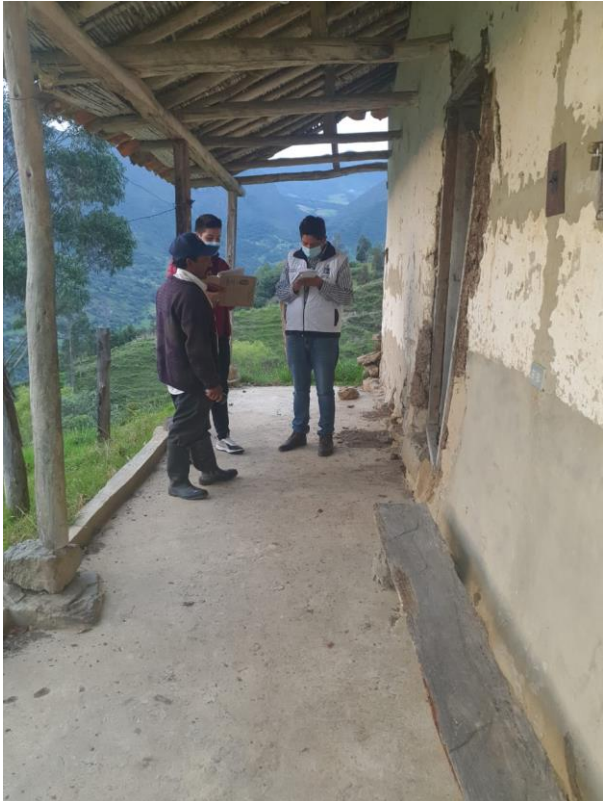
Fotografía 12. Vivienda objeto de mejoramiento Elaboración. General de Boyacá
