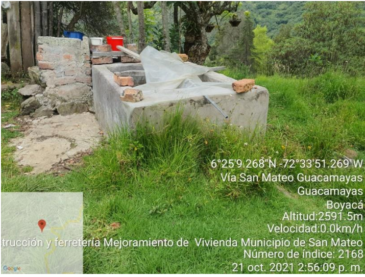
Fotografía 8. Vivienda objeto de mejoramiento Elaboración. Contraloría General de Boyacá
