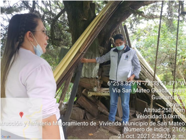
Fotografía 7. Evidencia de material barra corrugada de 1/2" Elaboración. Contraloría General de Boyacá
