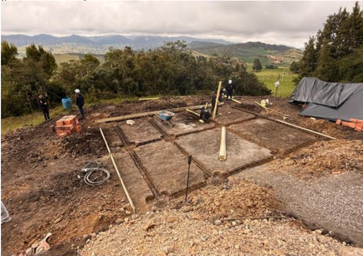
Figura 18. Acero de refuerzo en cimentación
