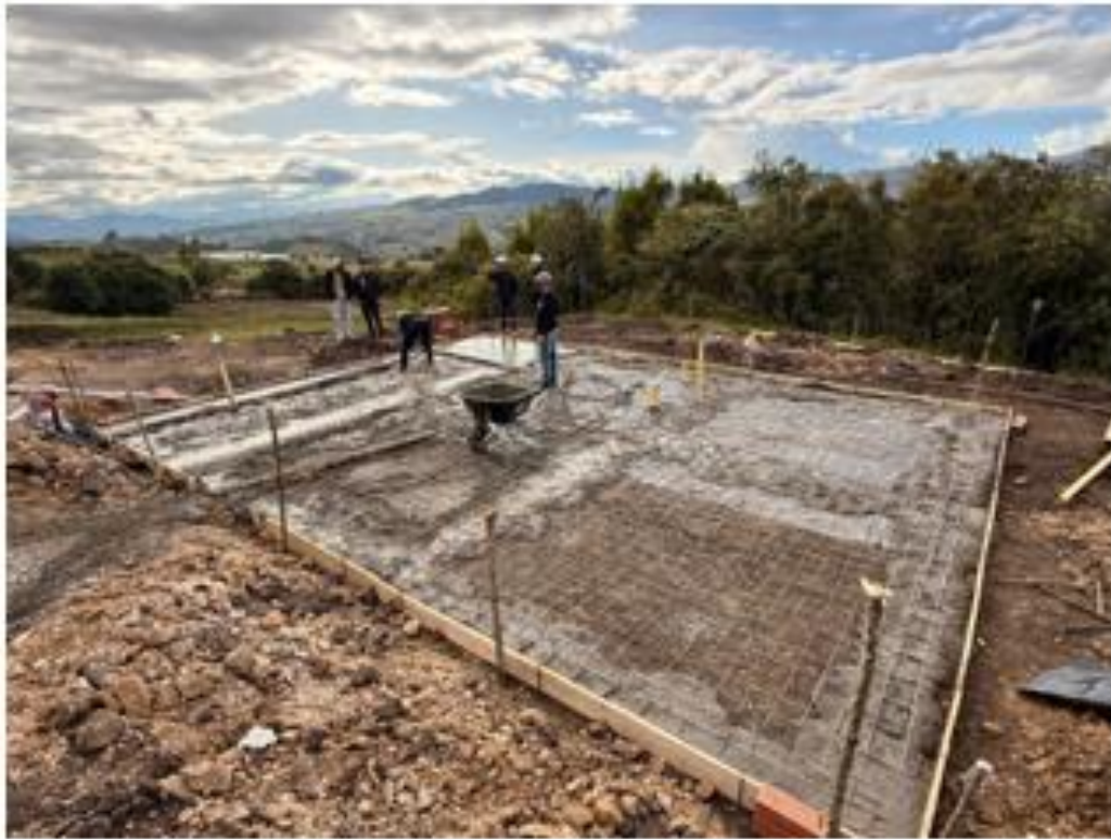
Figura 19. Losa de cimentación
