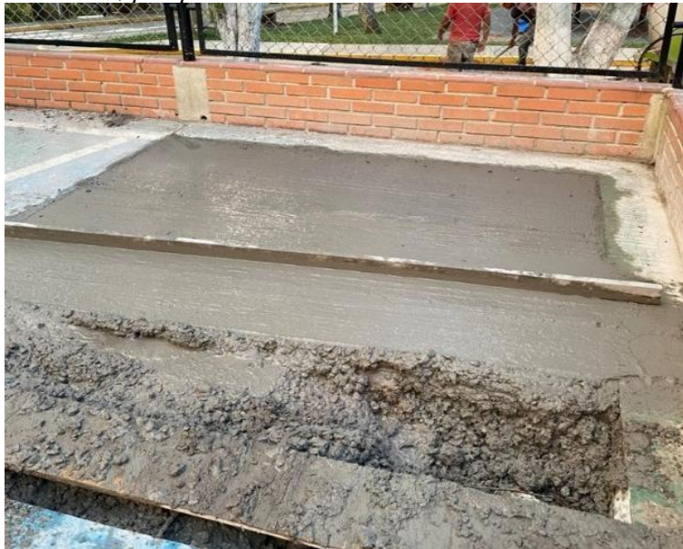
Figura 7. Reemplazo de losa, parque INTRA
