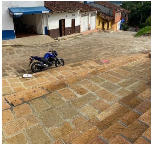
Figura 6. Reemplazo de piedra Barichara sector San Rafael
