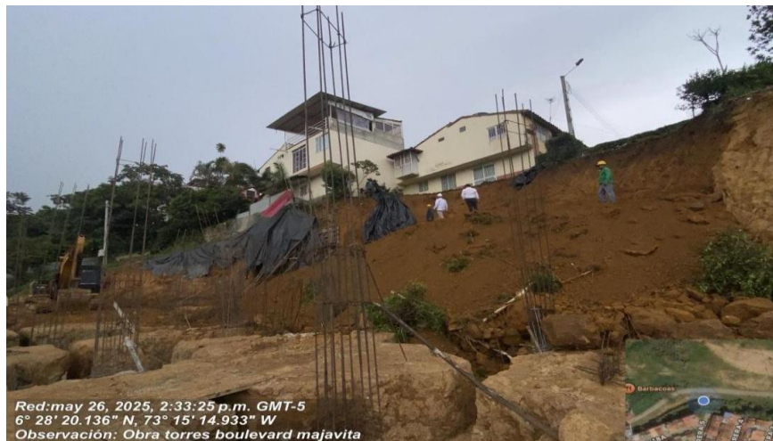
Figura 15. Construcción muro de contención
