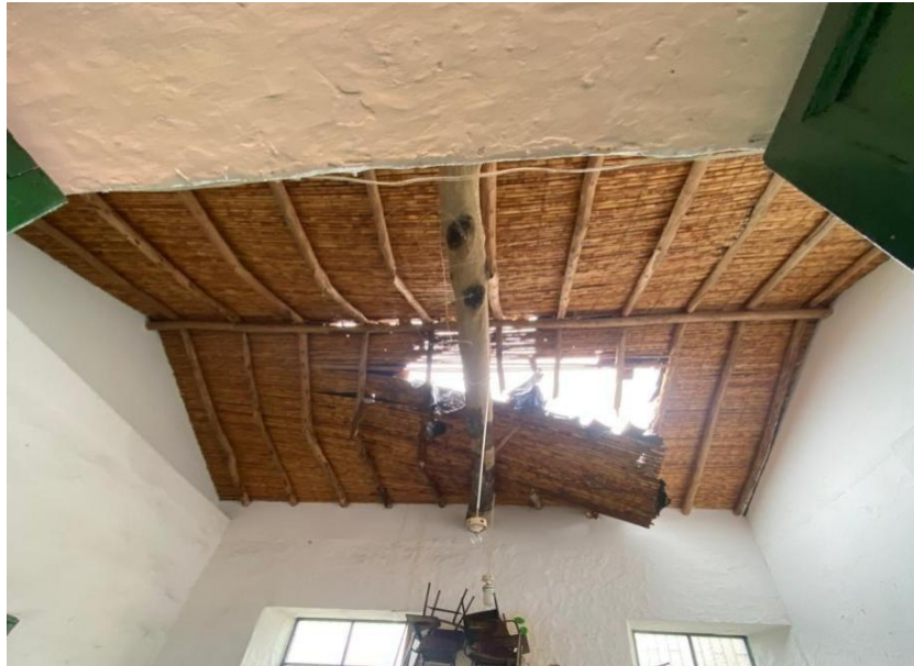
Figura 24. Escuela central de varones sede B
