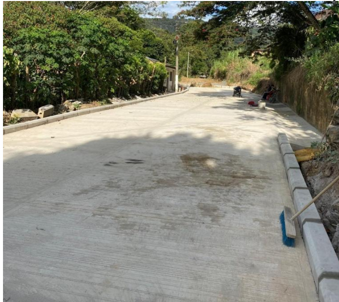
Figura 9. Pavimentación sector Puente García del barrio Primero de Mayo
