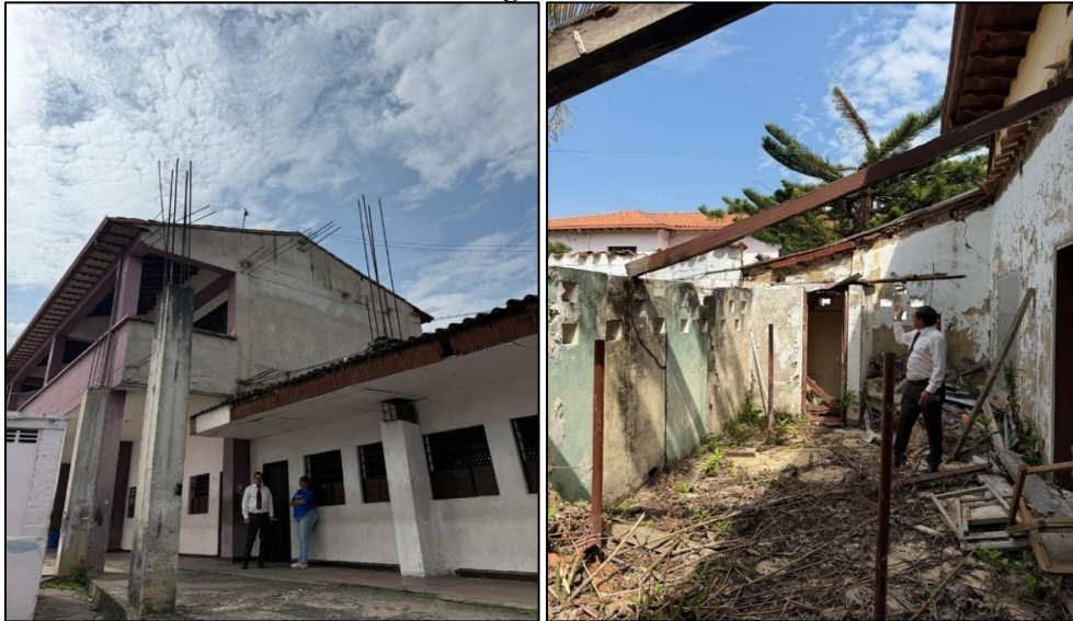
Figura 36. Visita técnica a la sede A del Colegio Universitario
