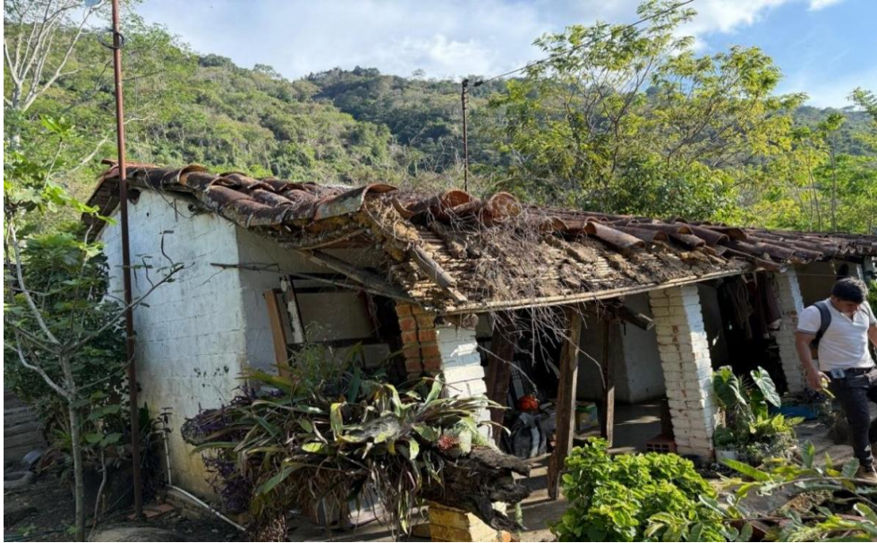
Figura 41. Vivienda vereda Luchadero
