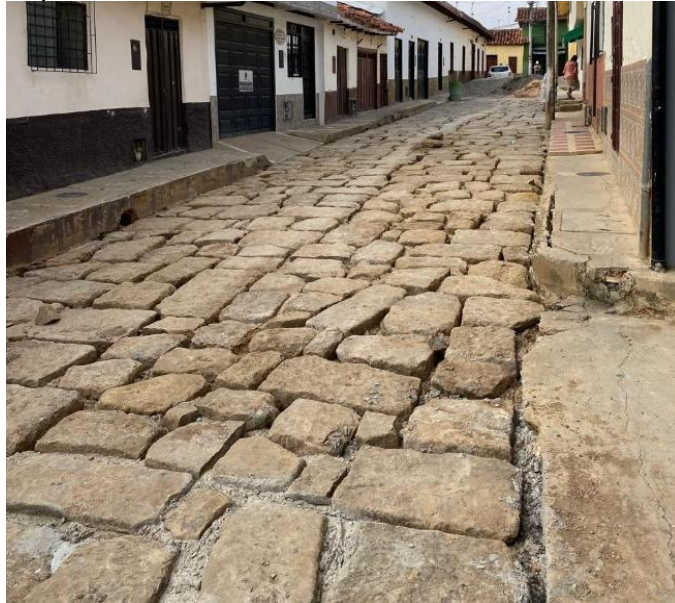
Figura 1. Instalación de piedra Barichara
