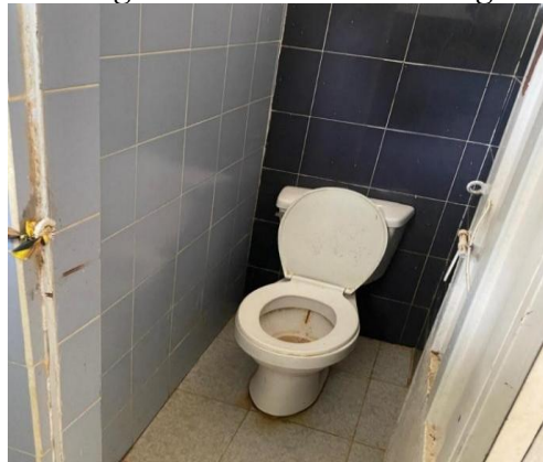
Figura 26. Unidades sanitarias Colegio Alberto Santos Buitrago.
