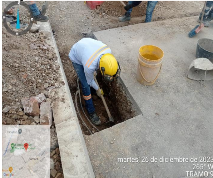
Figura 10. Excavación manual de sumidero.
