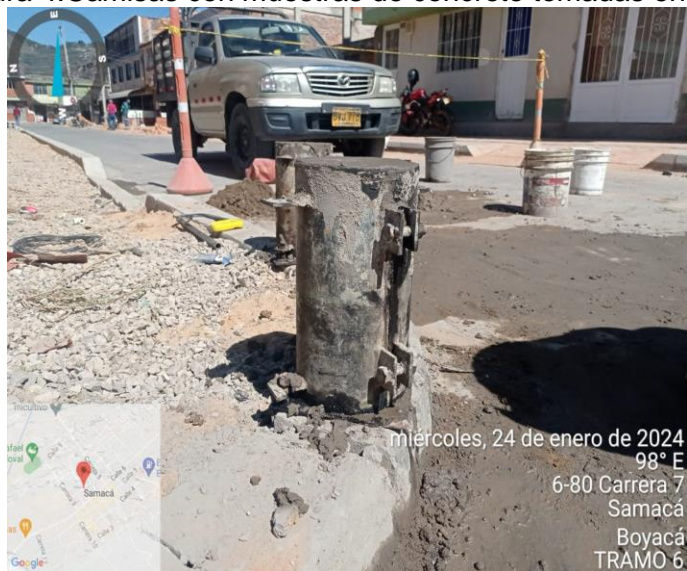
Figura 4. Camisas con muestras de concreto tomadas en sitio
