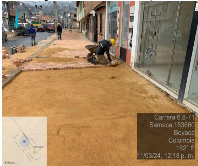
Figura 24. Instalación de adoquín.
