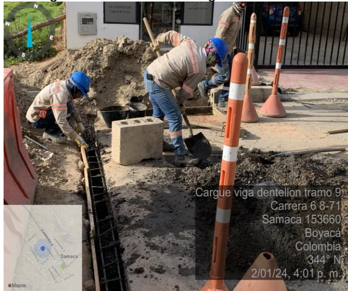
Figura 7. Instalación de viga dentellón.
