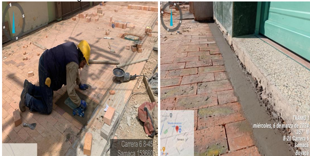
Figura 26. Instalación de cintas de confinamiento
