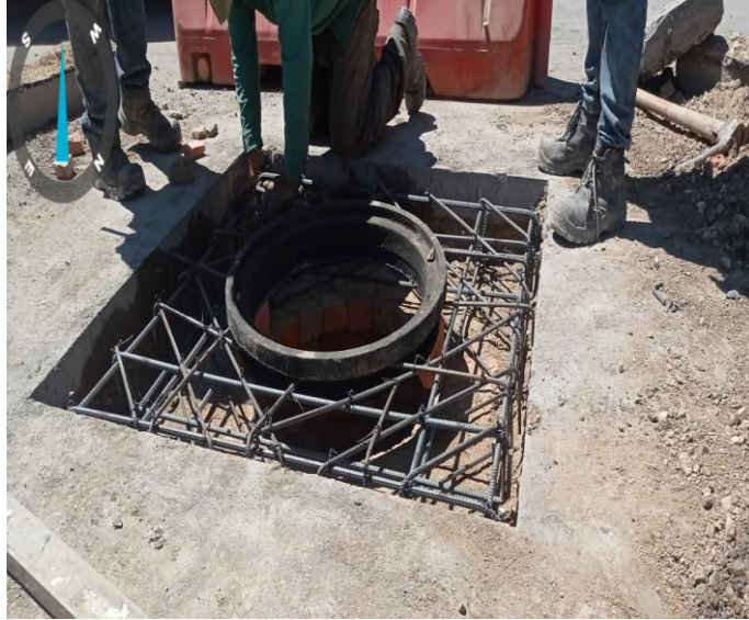
Figura 17. Figurado de acero, doble parrilla
