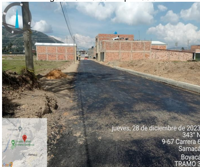
Figura 20. Vía con imprimación
