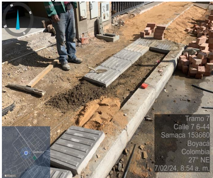
Figura 25. Instalación de losetas
