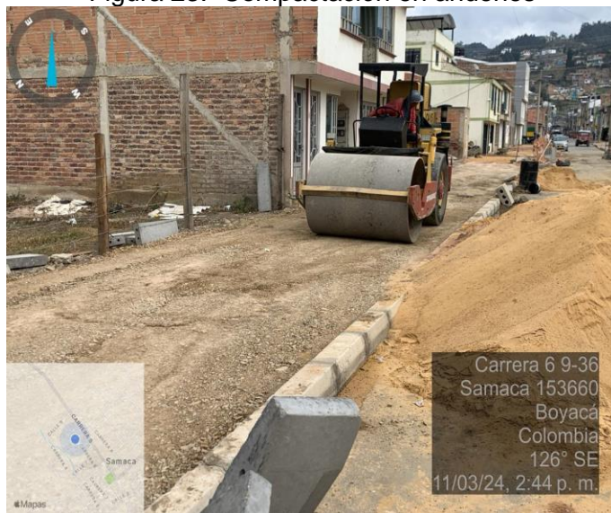
Figura 23. Compactación en andenes
