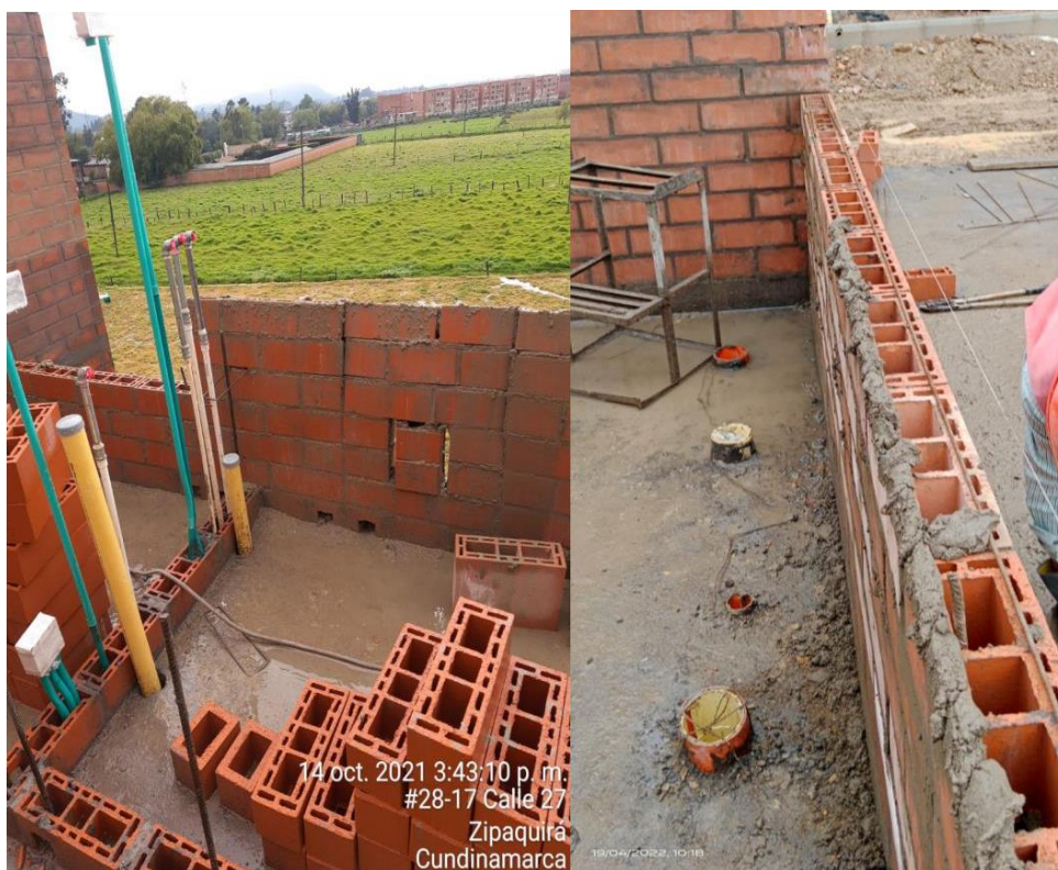
Figura 13: levantamiento de muros de mampostería. Fuente: Autor.
