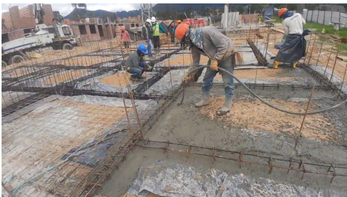
Figura 10: Fundida loza de contrapiso liberación de acero junto a supervisión técnica.
