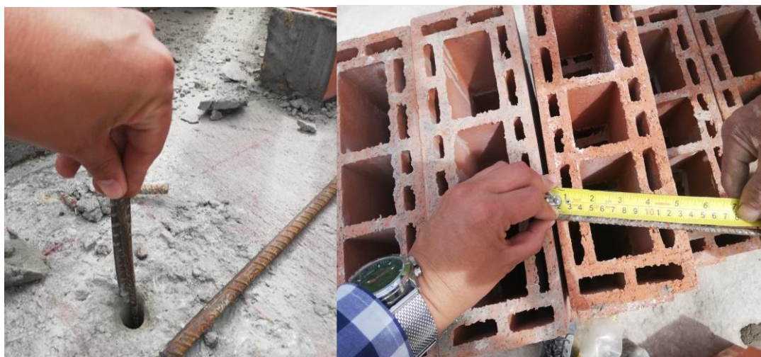
Figura 12: Liberación de perforaciones para anclajes. Fuente: Autor.
