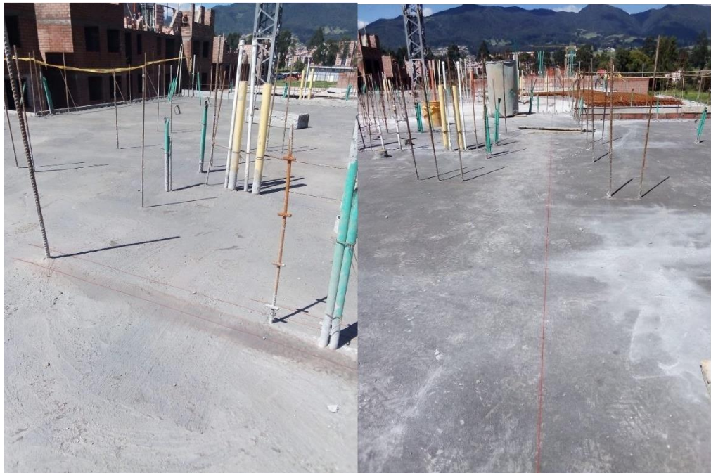
Figura 11: Replanteo y cimbrado de ejes. Fuente: Autor.
