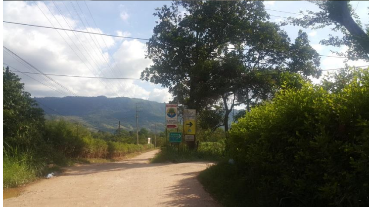
FOTO 3. TRASVERSAL GUATIGUARÁ DESPUES DEL LA PLANTA HIPINTO.
