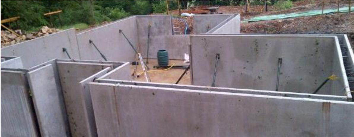
Figura 102. Doble muro en concreto
