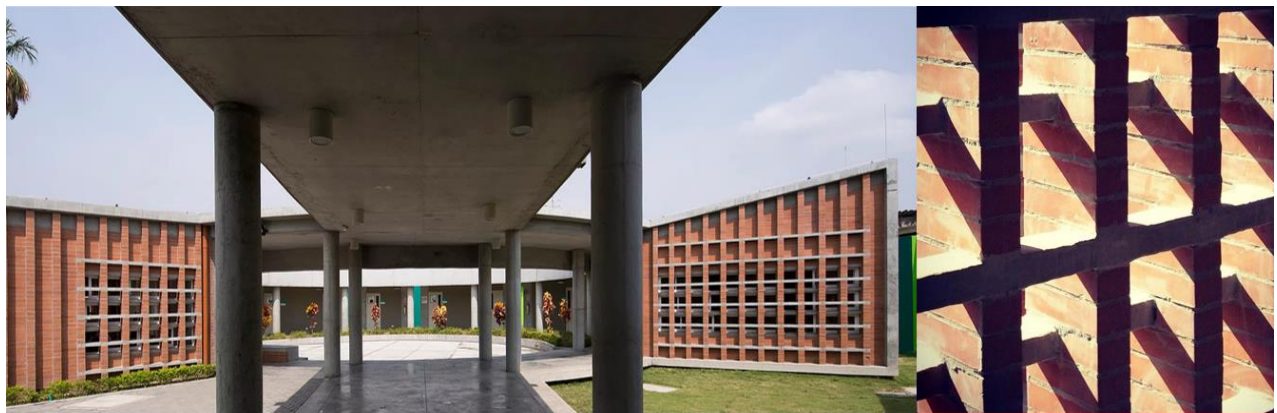
Figura 13. Ladrillo a la vista
