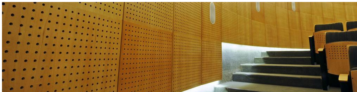
Figura 107. Panel acústico de madera en interior de un auditorio
