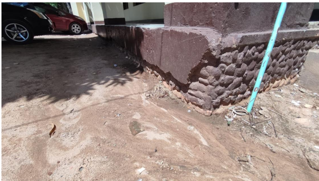
Figura 3. Tipo de cimentación encontrada en unos de los bloques de la institución
