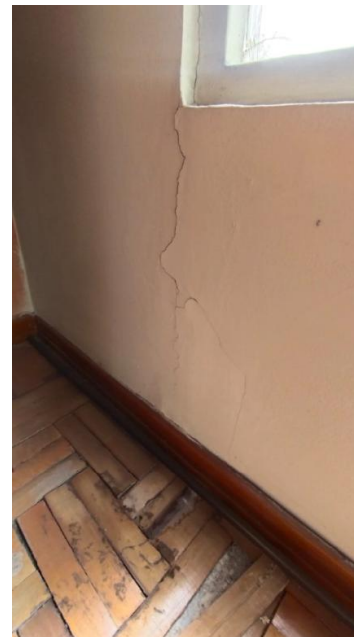
Figura 9. Fisura antepechos
