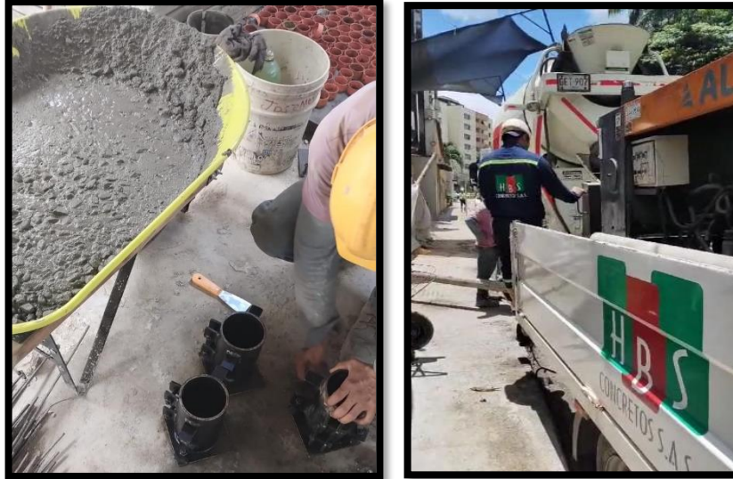
Ilustración 15 Toma de muestras para realización de cilindros
