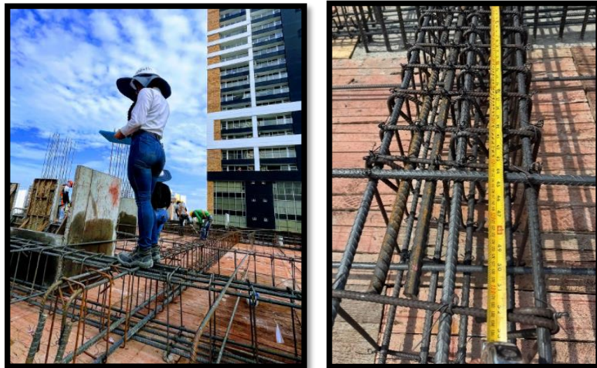
Ilustración 9 Verificación de vigas y viguetas
