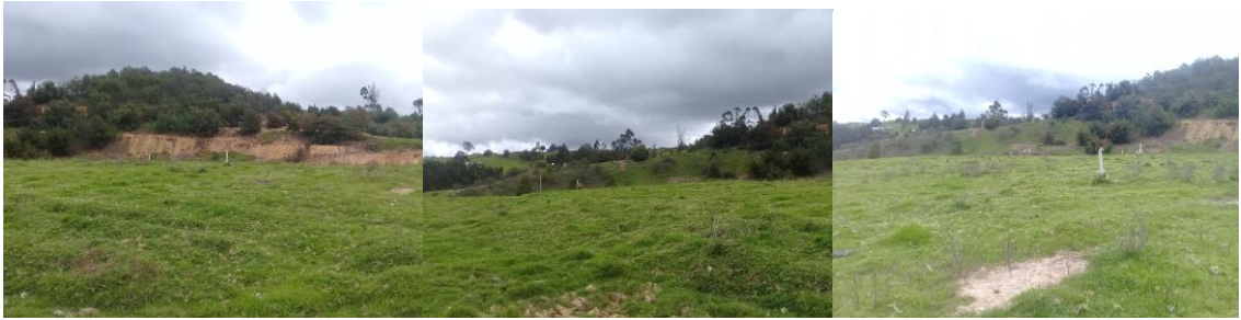
Figura 11. Antiguo relleno sanitario del municipio de Villapinzón
