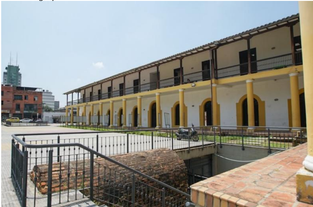
Figura 14. Fotografía externa Centro Cultural del Oriente.
