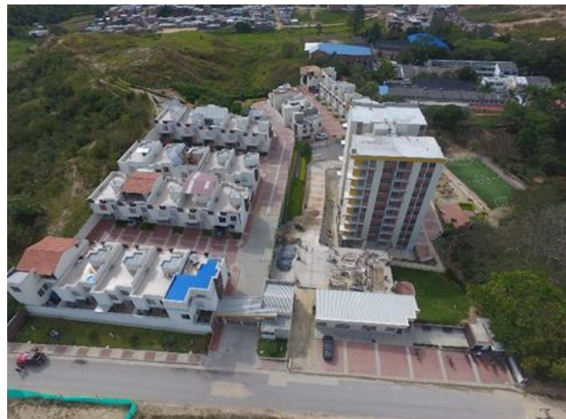
Figura 24. Conjunto Residencial Parque 34- Sector Filipote
