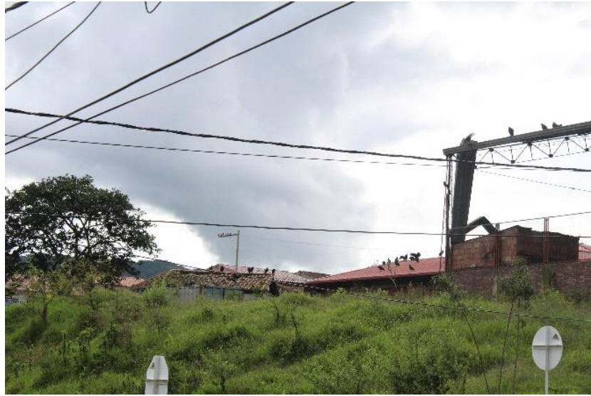
Figura 25. Cubierta de la plaza de mercado
