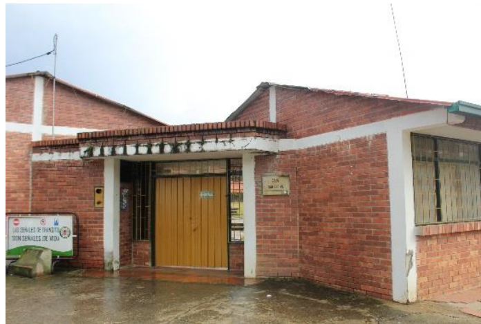
Figura 24. Casa campesina y actual estación de Bomberos
