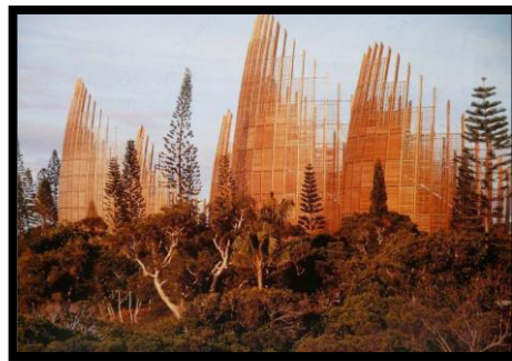
Figura 13 Imagen fachada del centro cultural
