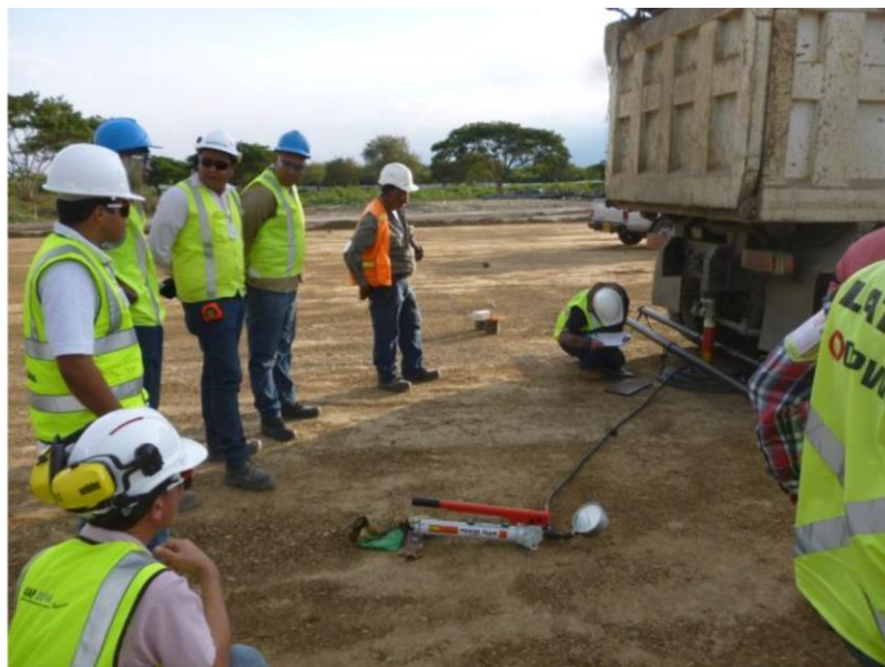
Figura. 15 Realización de ensayo de placa con carga estática
