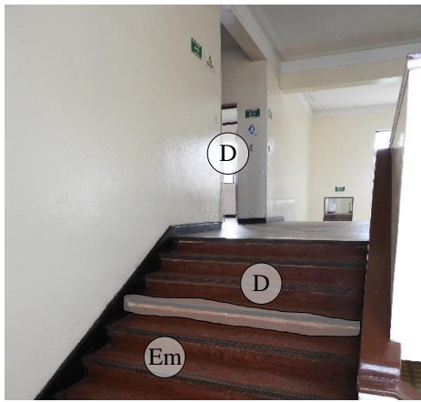
1. Acabado de escalera.
