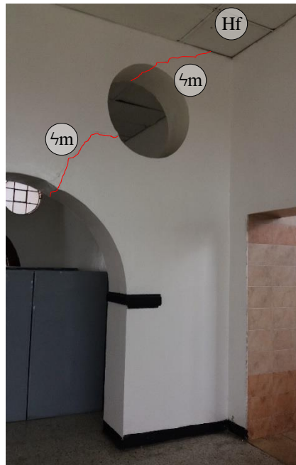
4. Muros y Guarda escobas.
