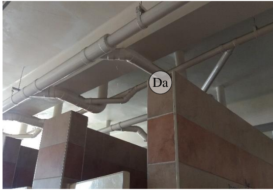
1. Cielo rasos y muros.
