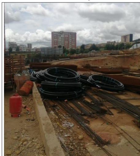
Figura 10. Descargue en la obra de la tubería de polietileno de alta densidad.
