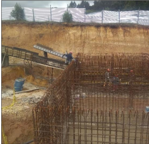
Figura 5. Fundida de la placa del tanque realizada el día 25 de octubre.
