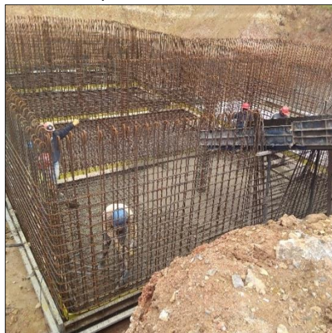
Figura 4. Fundida de la placa del tanque realizada el día 4 de octubre.
