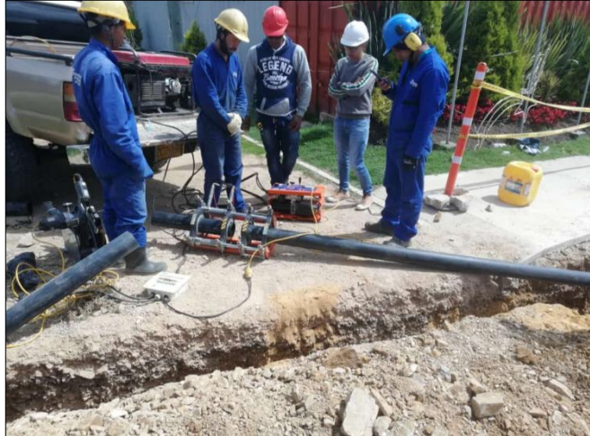
Figura 11. Instalación del carro alineador.
