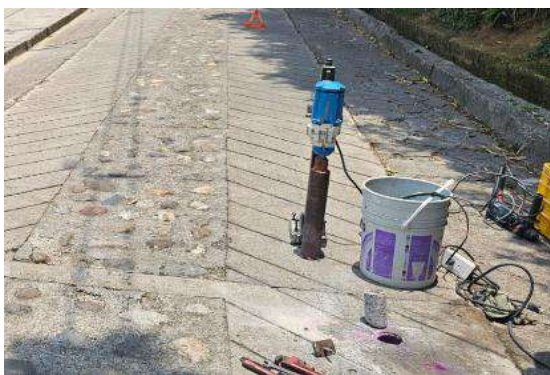
Ilustración 53. Extracción Núcleo No 2.
