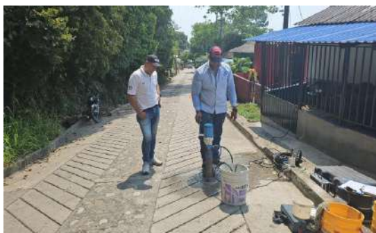
Ilustración 49. Extracción Núcleo No 1.
