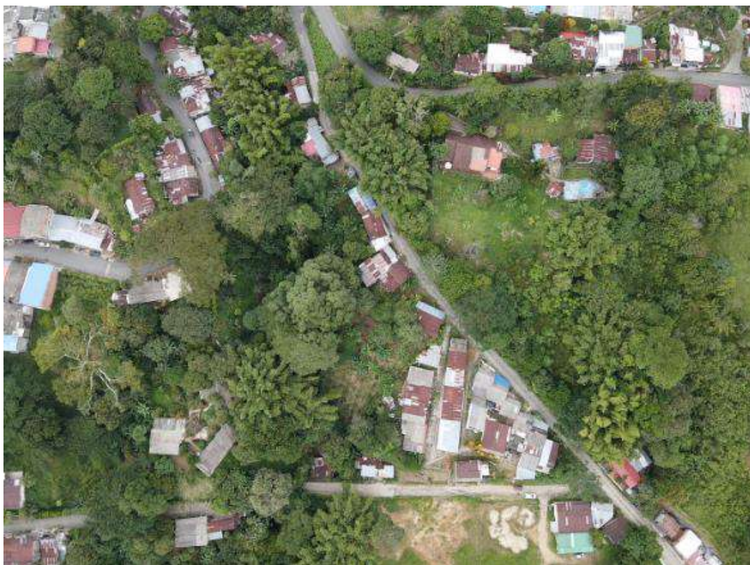
Ilustración 44. Vista aérea de la vía.
