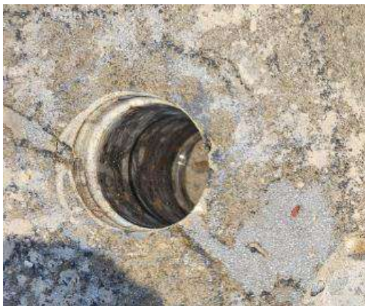
Ilustración 62. Orificio Extracción Núcleo No2.
