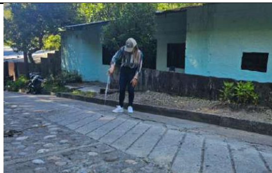
Ilustración 29. Verificación de espesor.
