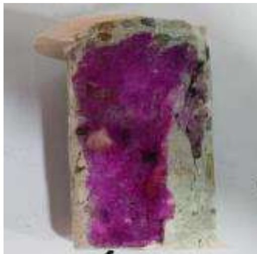
Ilustración 65. Carbonatación Fallo. Cilindro No2.
