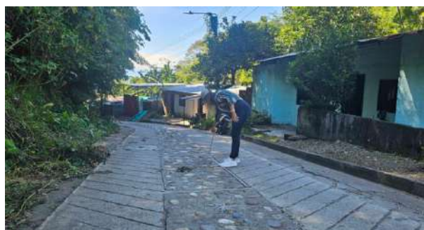
Ilustración 26. Verificación de medidas placa huella.
