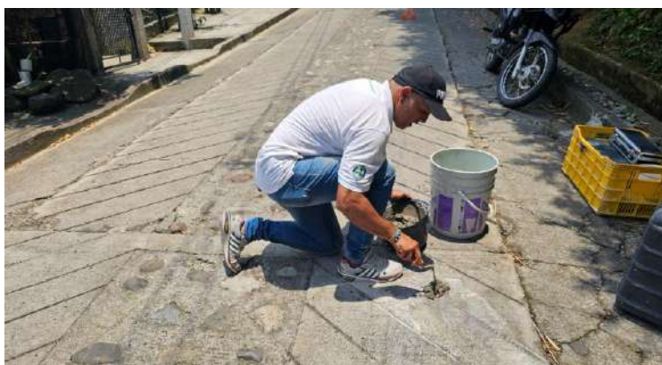
Ilustración 55. Taponamiento de los Orificios.
