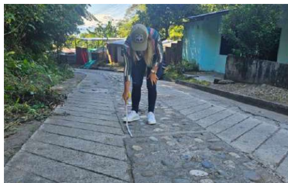
Ilustración 28. Verificación de anchos viga riostra.
