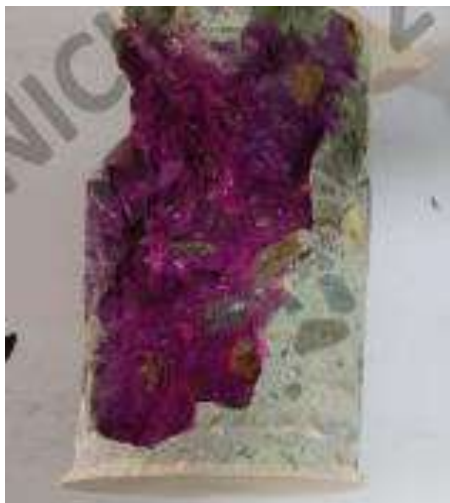
Ilustración 64. Carbonatación Fallo Cilindro No1.
