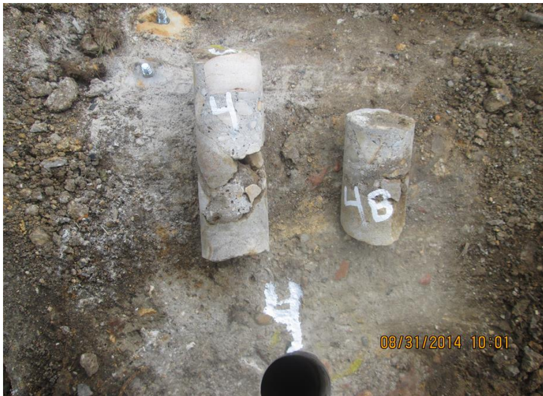
Figura 10 Recuperación del núcleo No. 4, obsérvese las cavidades que presenta el concreto. Fuente: Propia
