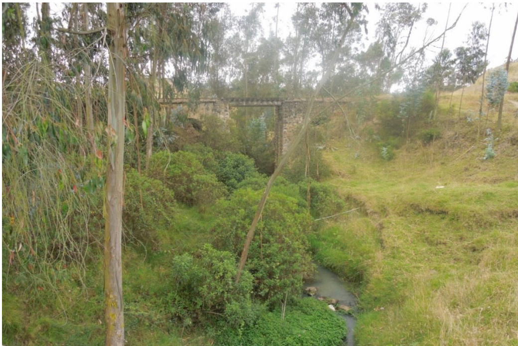
Figura 46 Otro detalle del talud. Fecha 12 abril 2014 Fuente: Propia
