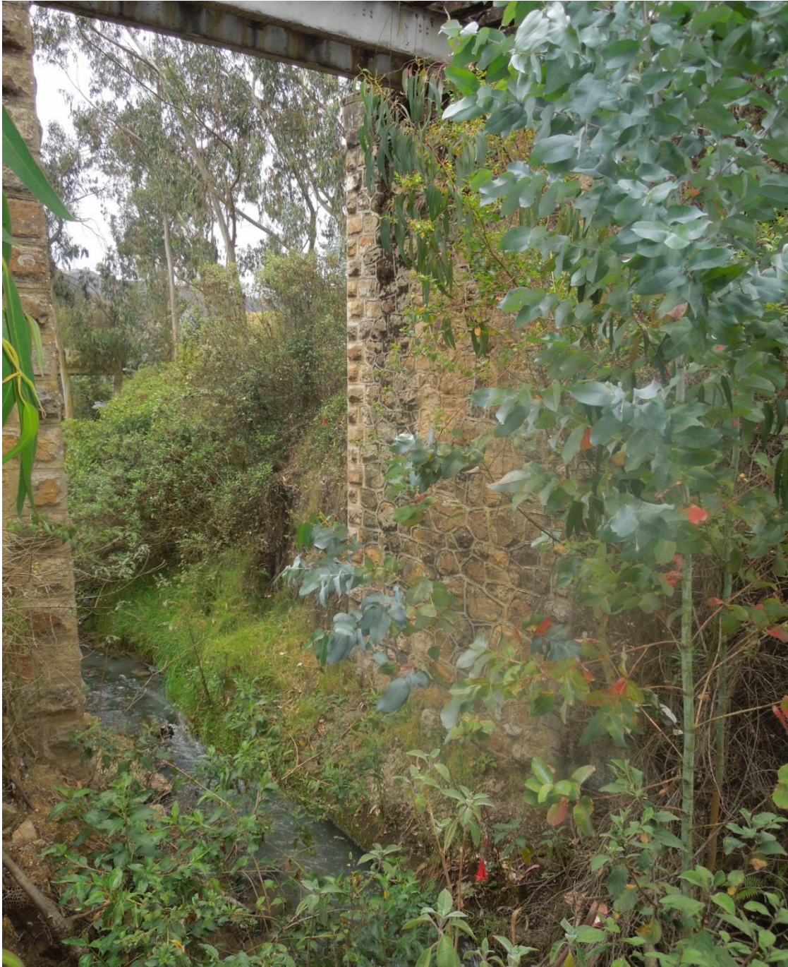
Figura 57 Nótese la verticalidad de las paredes de las pilas Fuente: Propia
