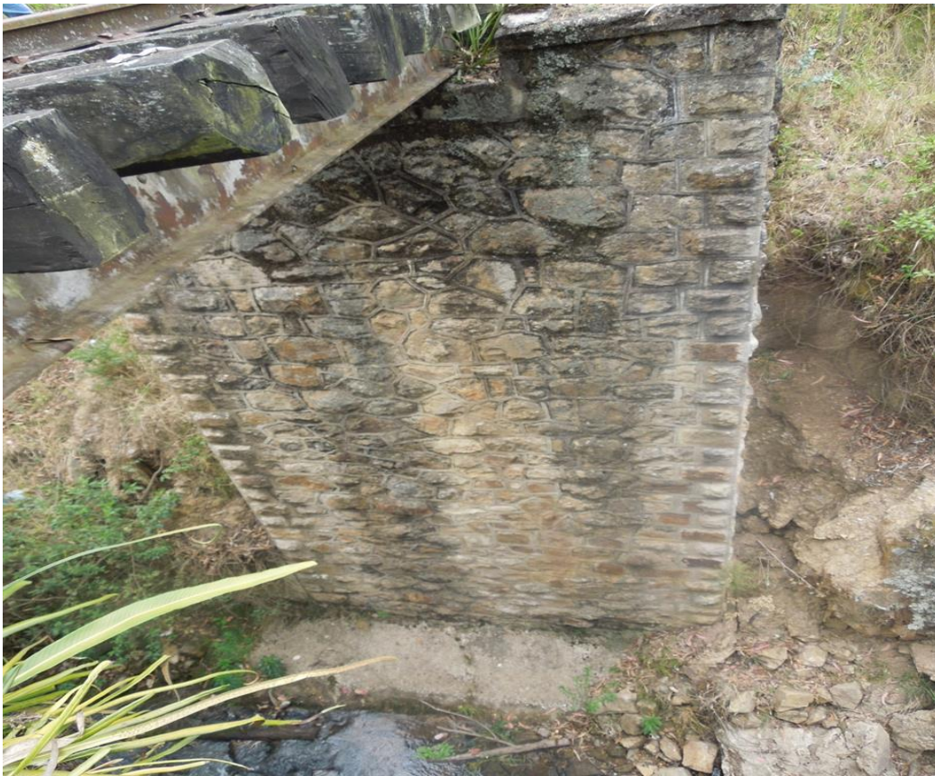
Figura 6 Pilas en mampostería MD. Fuente: Propia
