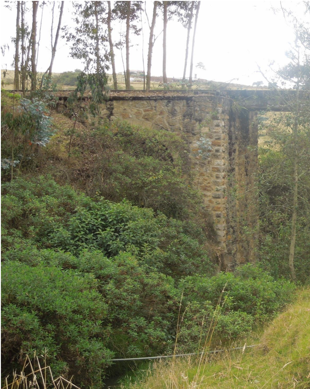
Figura 34 Vista del Arco # 2, aguas arriba Fuente: Propia
