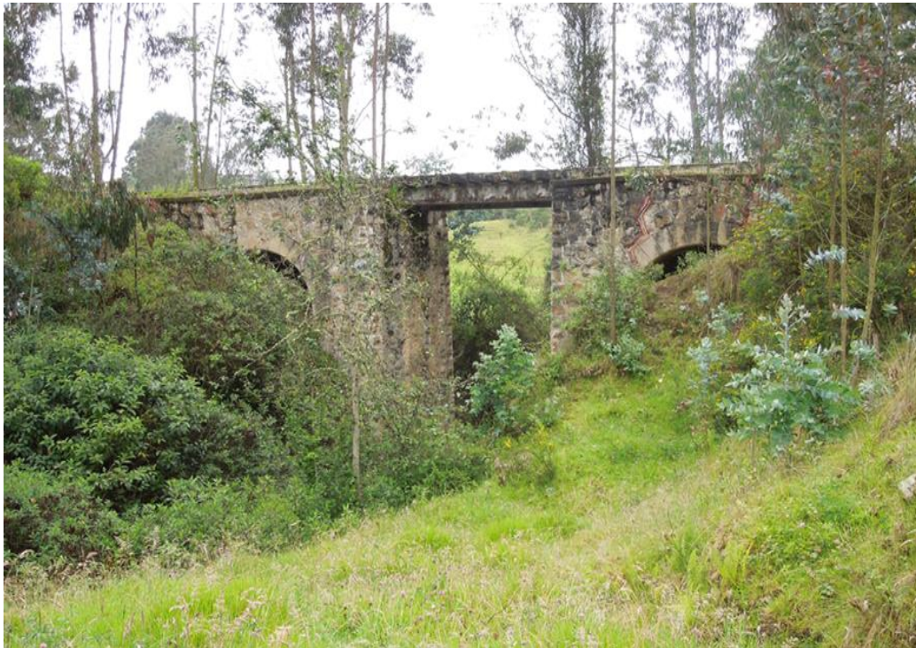
Figura 3 Vista longitudinal del puente. Fuente: Propia
