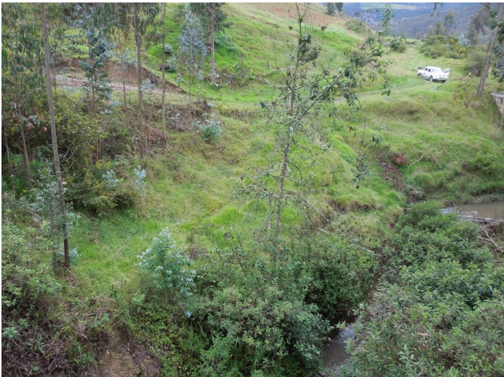
Figura 48 Vista talud MD aguas arriba de fecha 9-agosto 2014 Fuente: Propia
