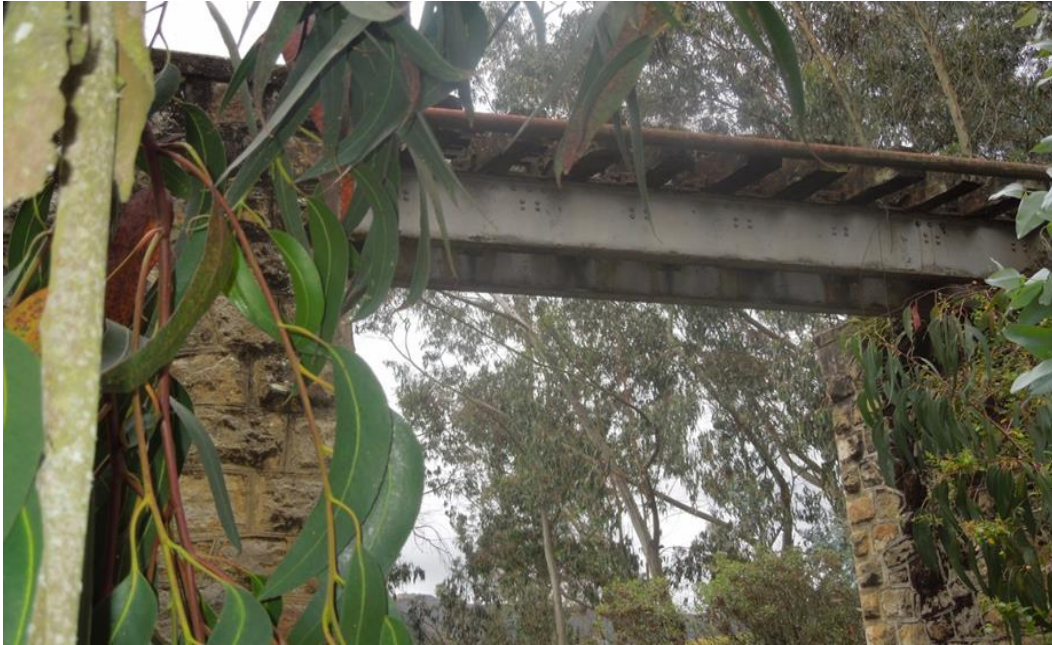
Figura 5 Detalle luz central – Vigas metálicas de alma llena. Fuente: Propia
