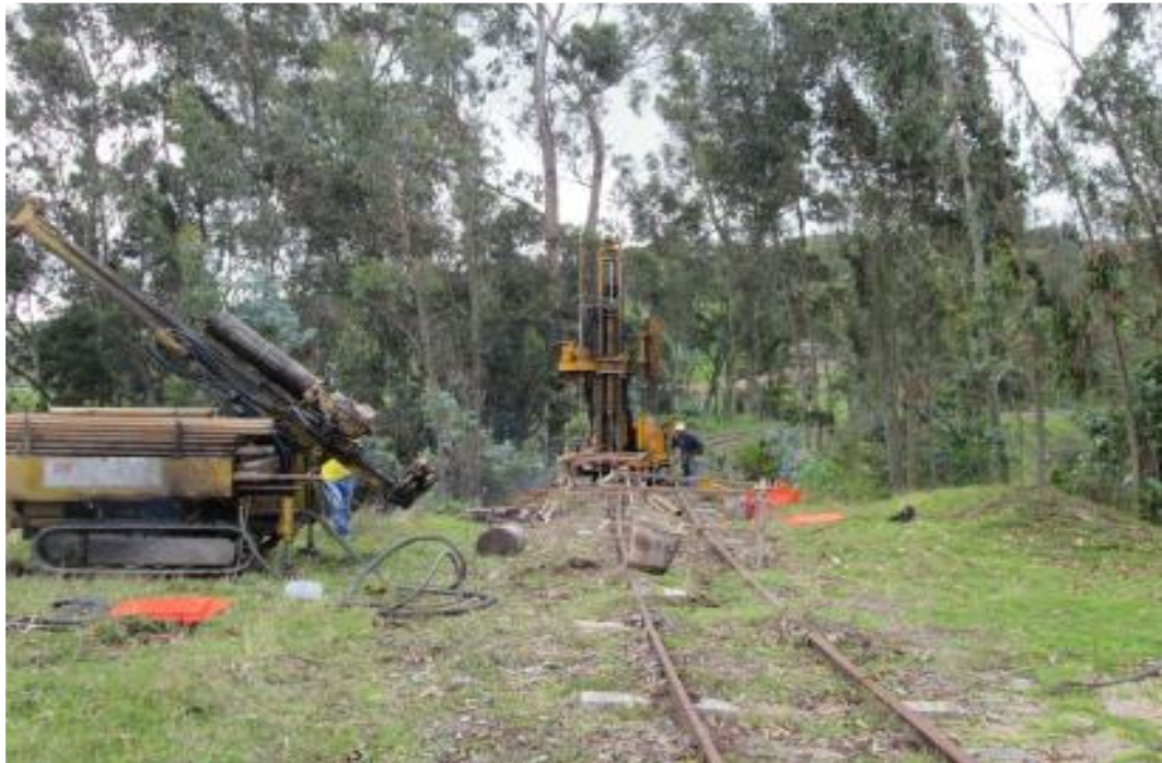
Figura 17 Realización de sondeos Fuente: Propia
