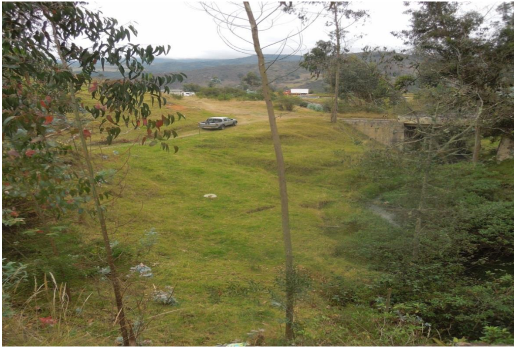
Figura 47 Vista del talud MD aguas arriba. Fecha: 12 - abril - 2014 Fuente: Propia
