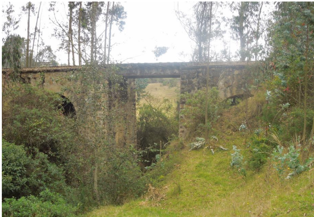
Figura 4 Vista longitudinal del puente Fuente: Propia
