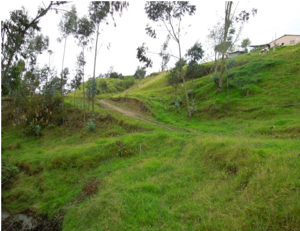
Figura 50 Vista del talud MD aguas arriba. De fecha 9-agosto 2014 Fuente: Propia
