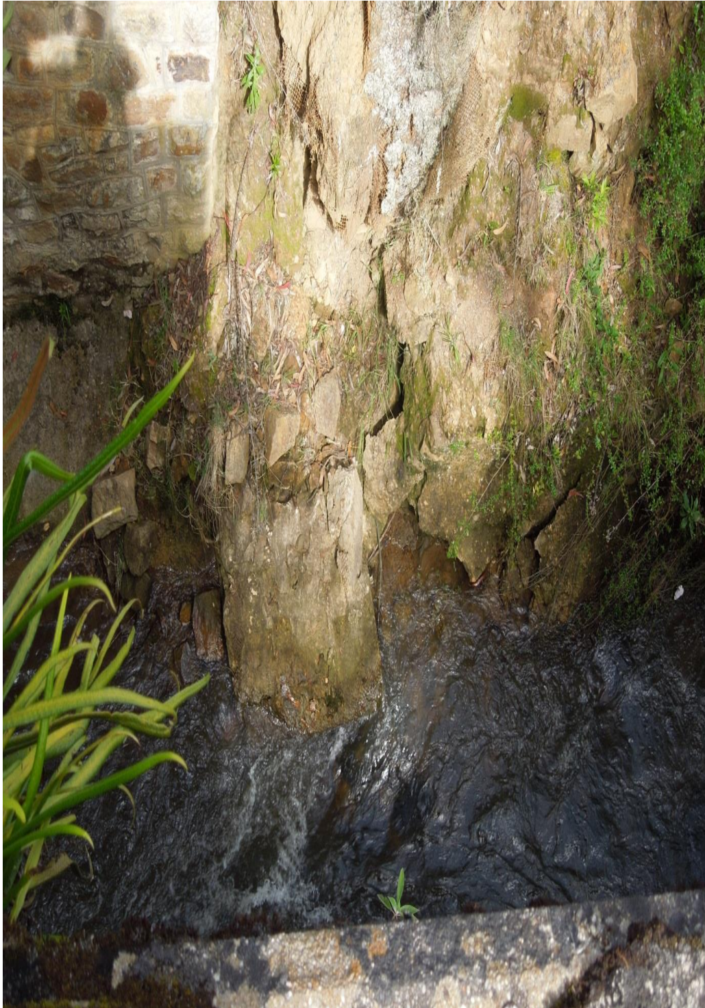
Figura 54 Talud MD aguas arriba. Otro detalle del bloque de material sobre el lecho de la Qda. Y la cuña próxima a desprenderse. De fecha 9-agosto 2014 Fuente: Propia
