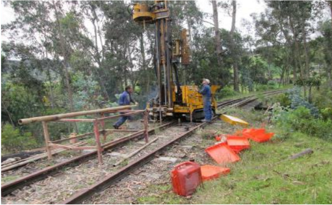
Figura 18 Realización de sondeos Fuente: Propia
